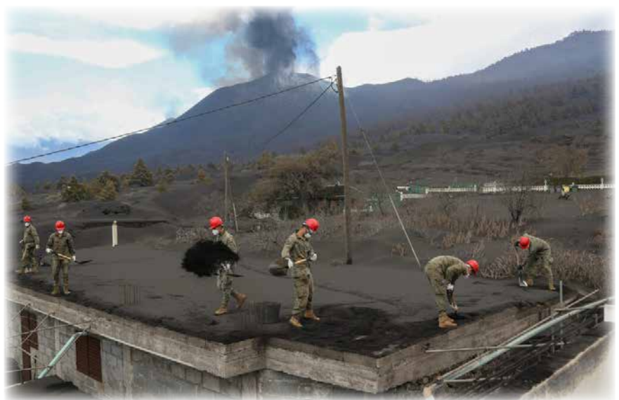
Militares del Ejército de Tierra limpian la ceniza de los tejados de las viviendas, en la localidad de Las Manchas, La Palma
