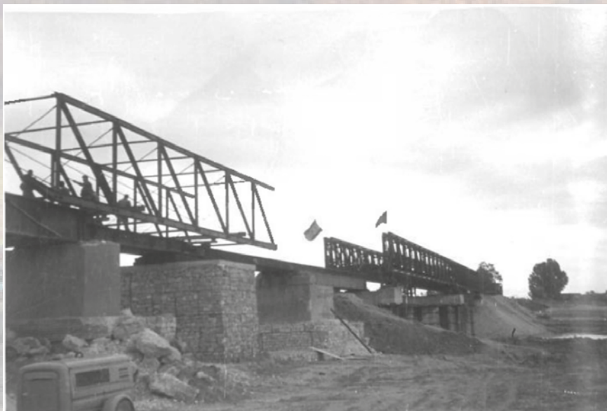
Fotografía 8. Puente de f. c. ayuda a Túnez
