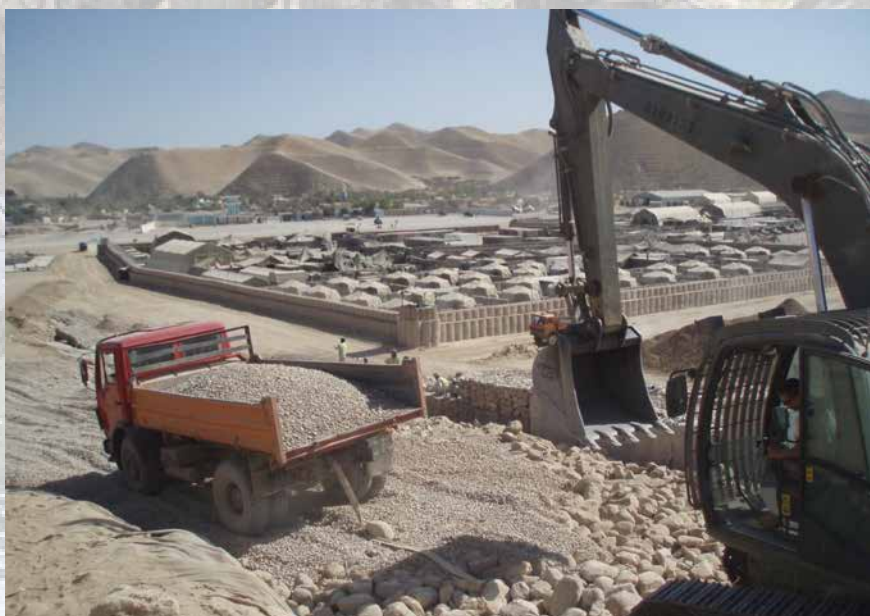
Fotografía 9. Construcción PSB en QeN, Afganistán
