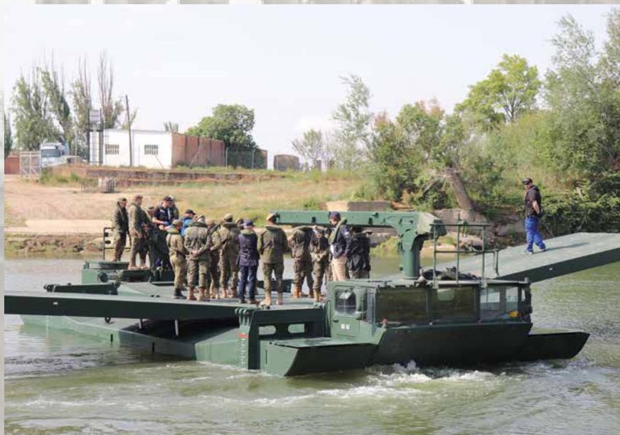
Fotografía 12. Pruebas del puente flotante M3
