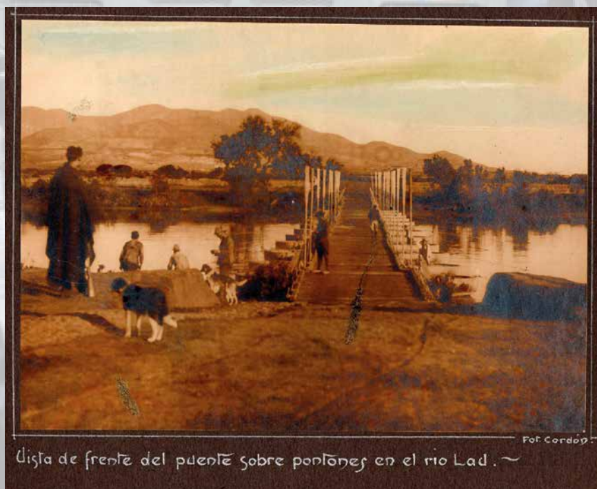
Fotografía 6. Vista del puente sobre el río Lau
