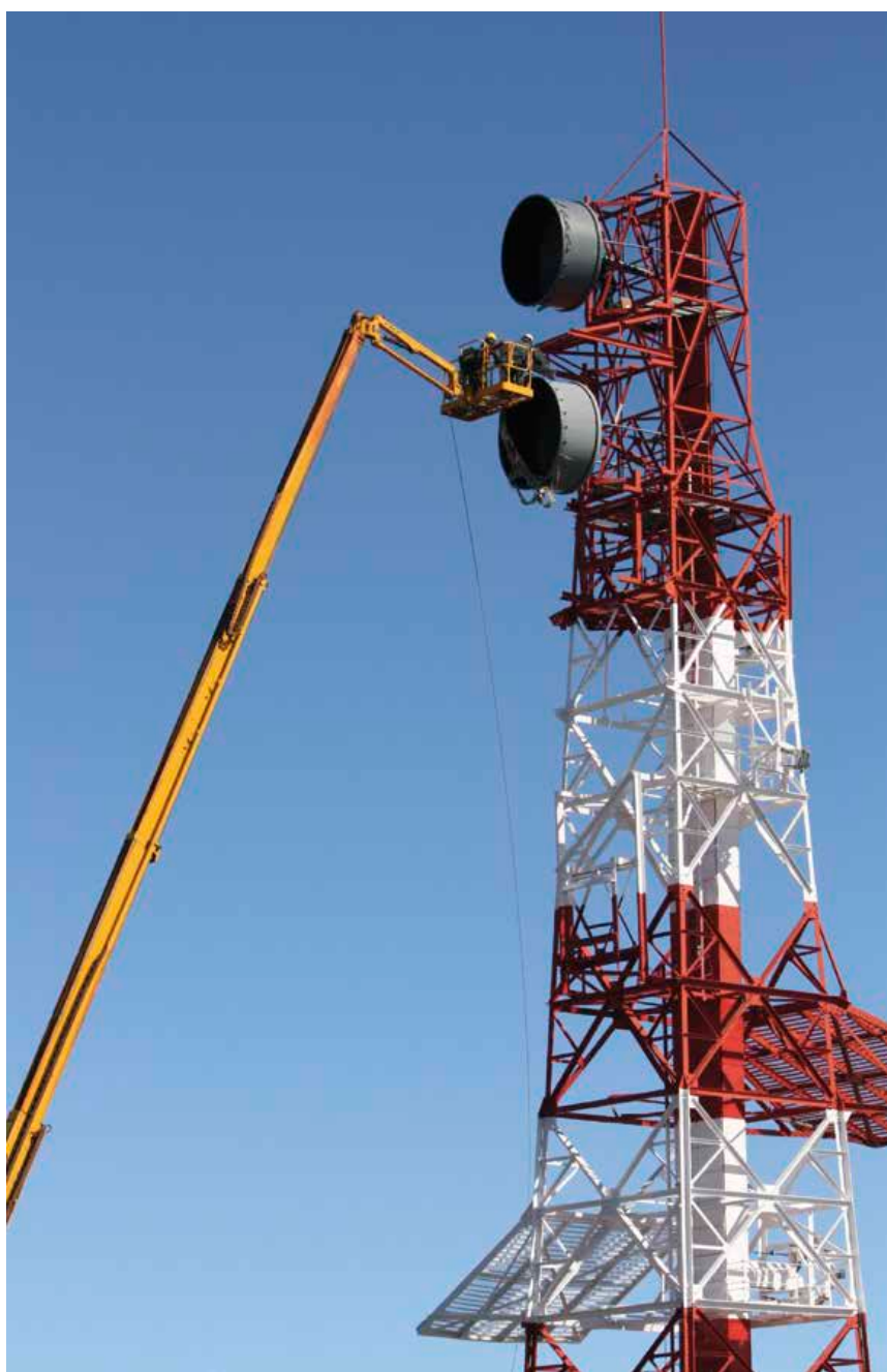
Trabajos de mantenimiento de antenas a gran altura. Tenerife, 2012
