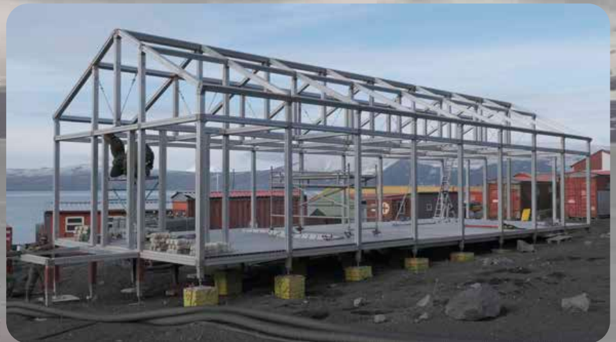
Montaje del módulo de taller MING
