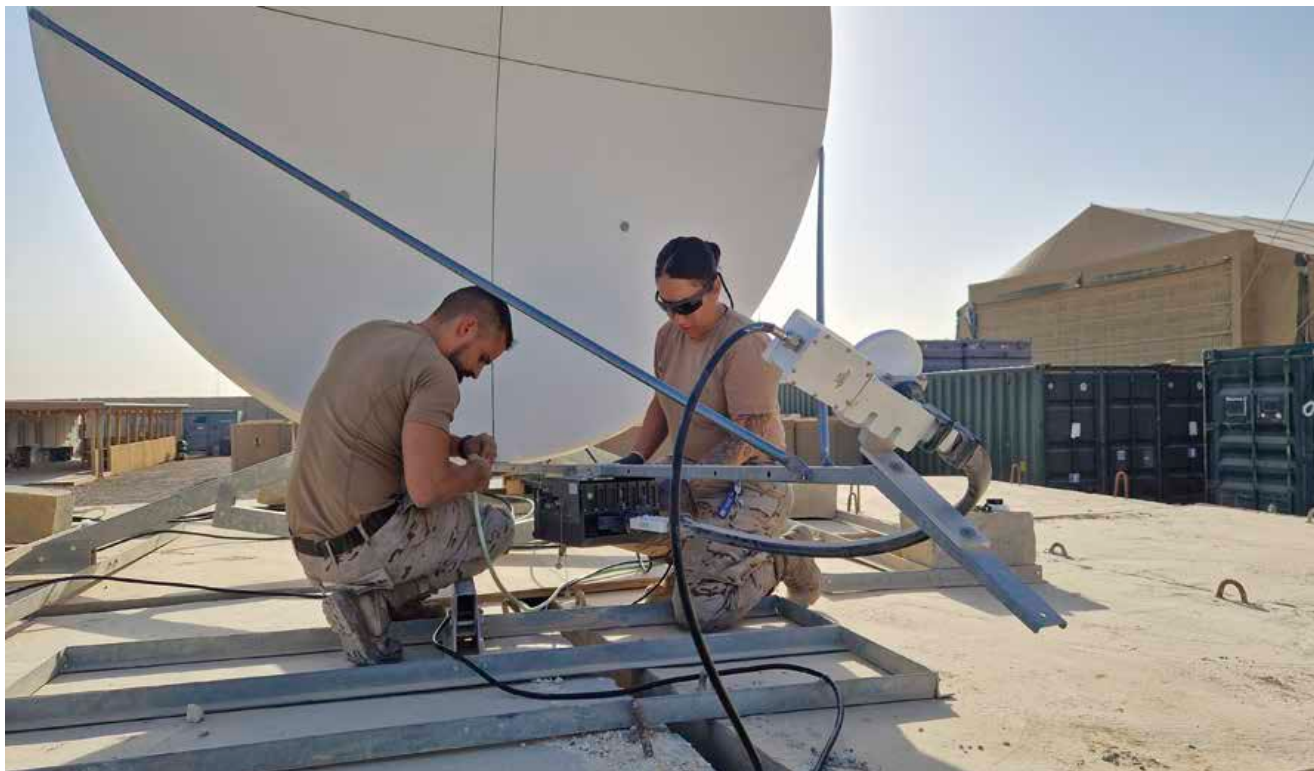
Trabajos de instalación y mantenimiento de terminales satélite en Zona de Operaciones. Irak, 2023
