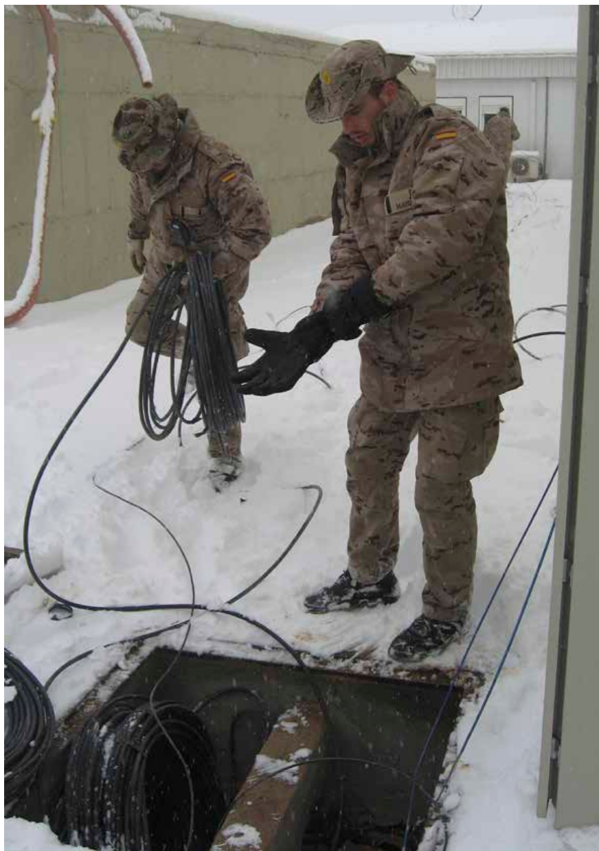
Trabajos de infraestructura CIS en Zona de Operaciones. Afganistán, 2011
