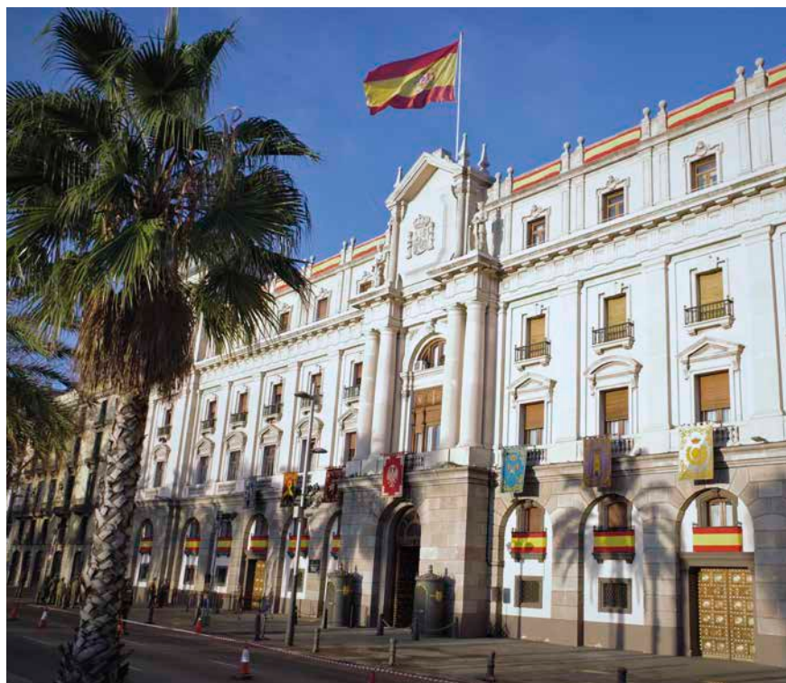
Fachada del edificio de Capitanía en Barcelona
