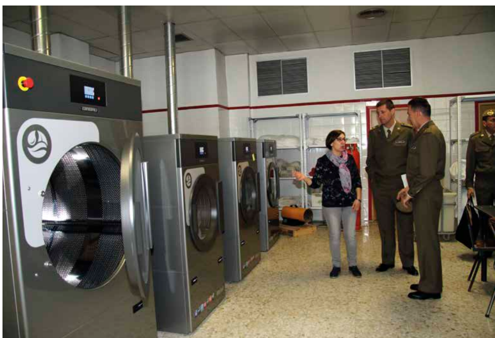
Visita a las instalaciones de lavandería
