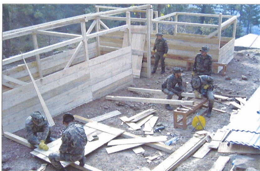
Efectivos de la Compañía de Ingenieros española construyen refugios en la localidad montañosa de Malot
