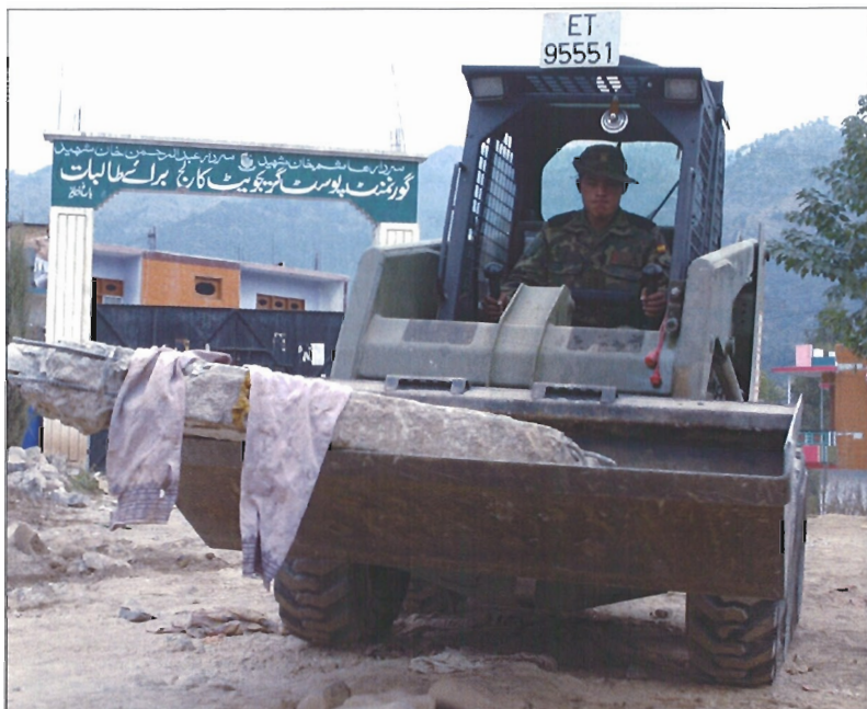
La Compañía de Ingenieros española efectúa labores de retirada de escombros en un colegio de niñas de Bagh
