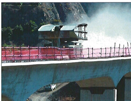
El Tijera protagonizó las pruebas de carga dinámicas en el viaducto
