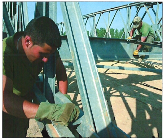
El soldado Comedera (en primer término), durante el montaje del puente Mabey
