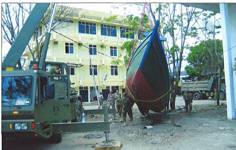
La Unidad de Ingenieros ha demostrado su preparación en la limpieza de calles y la reconstrucción de infraestructuras
