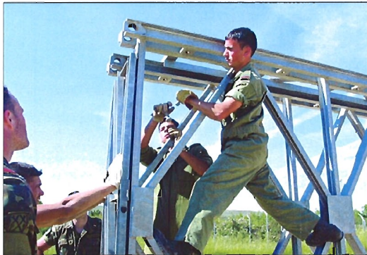
Durante el ejercicio se realizó el montaje de un puente Mabey
