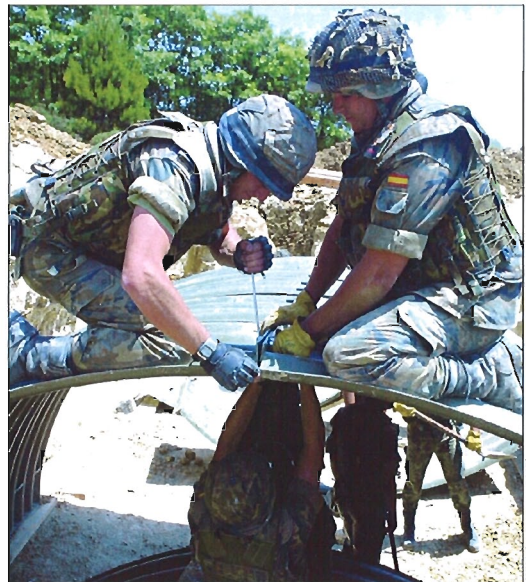
Una de las prácticas fue la preparación de un puesto de mando subterráneo
