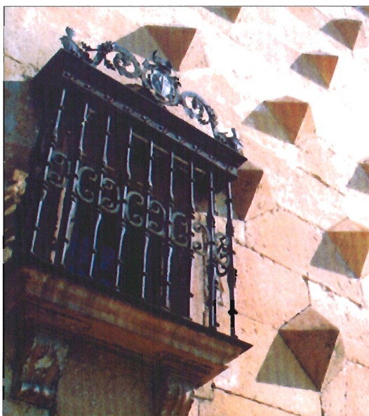
Detalle de la fachada del Palacio del Infantado
