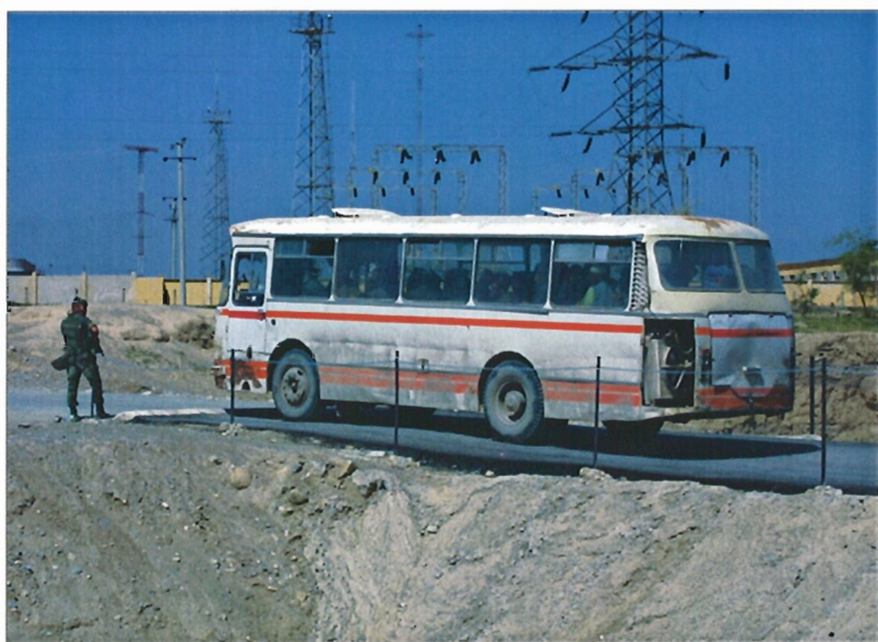
La Unidad de Ingenieros española ha construido un puente en la localidad de Pol-e-Charkhi
