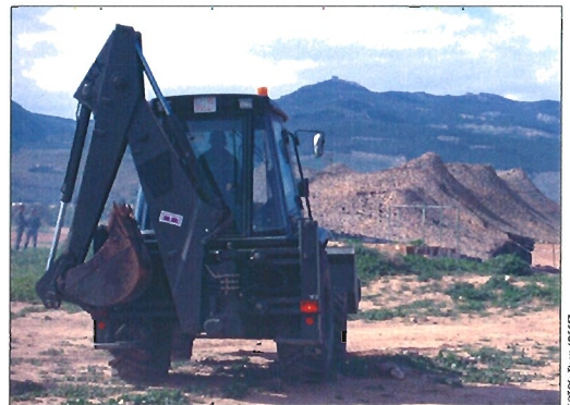
Retroexcavadora del RING nº 8 en una las prácticas habituales
