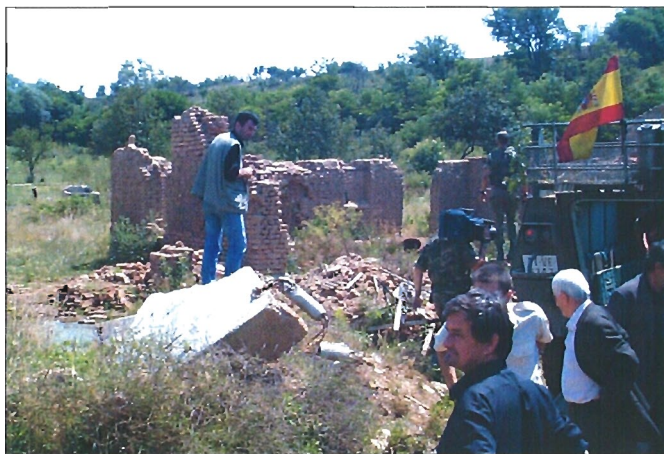
Los españoles proporcionan seguridad durante la reconstrucción de las viviendas
