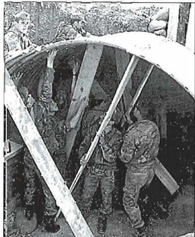
La UZAP prepara un puesto de mando subterráneo.
