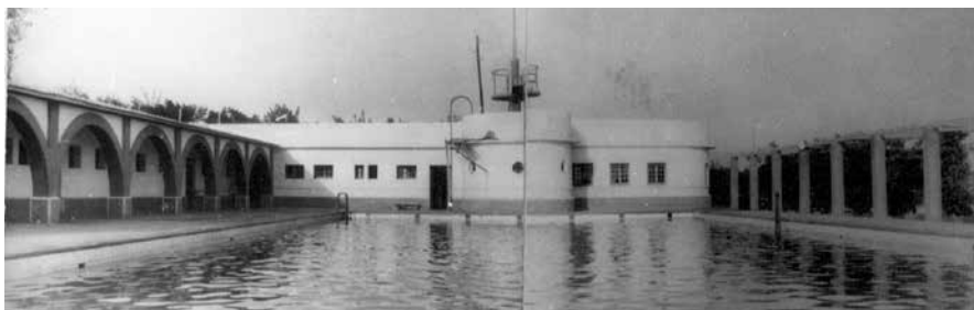
Tahuima. Vista general de la piscina
