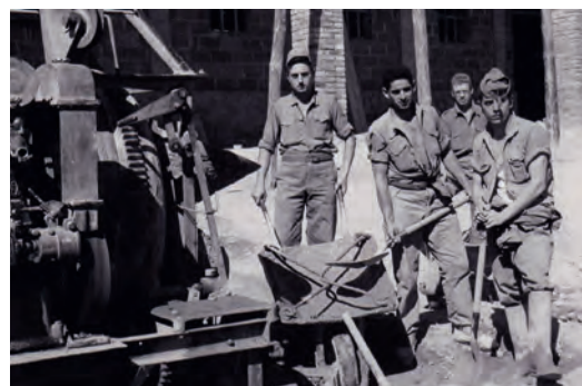
Construcción de los edificios de la Academia.
