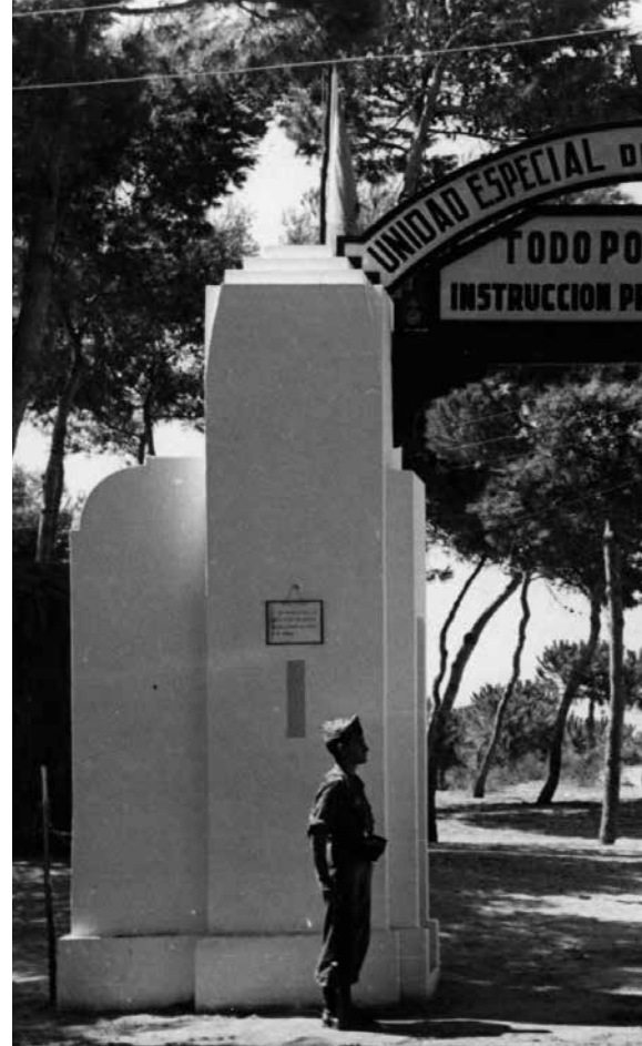
Acceso principal al campamento de la IPS de La Forestal en Rota (Cádiz) para Artillería de Costa
