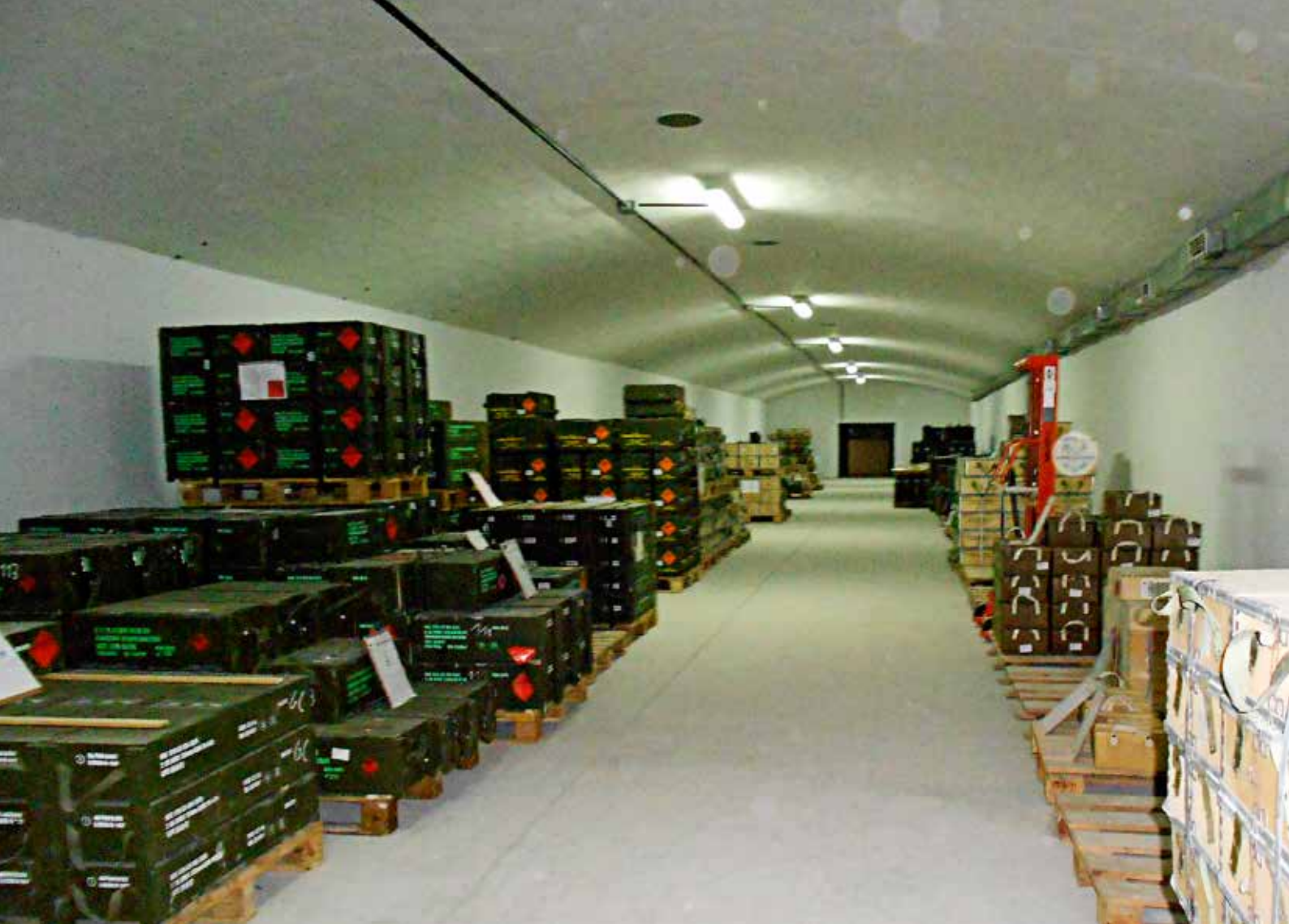
Almacén clase V (municiones y explosivos)
