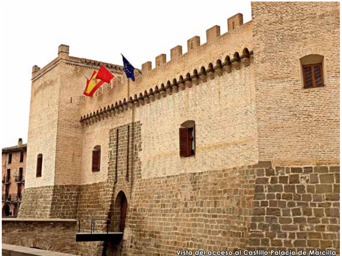
Vista del acceso al Castillo Palacio de Marcilla
