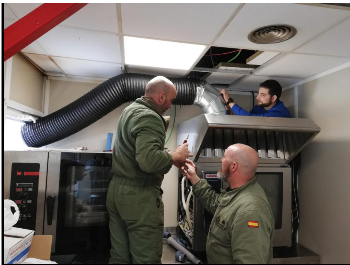
Colocación de extractor del horno
