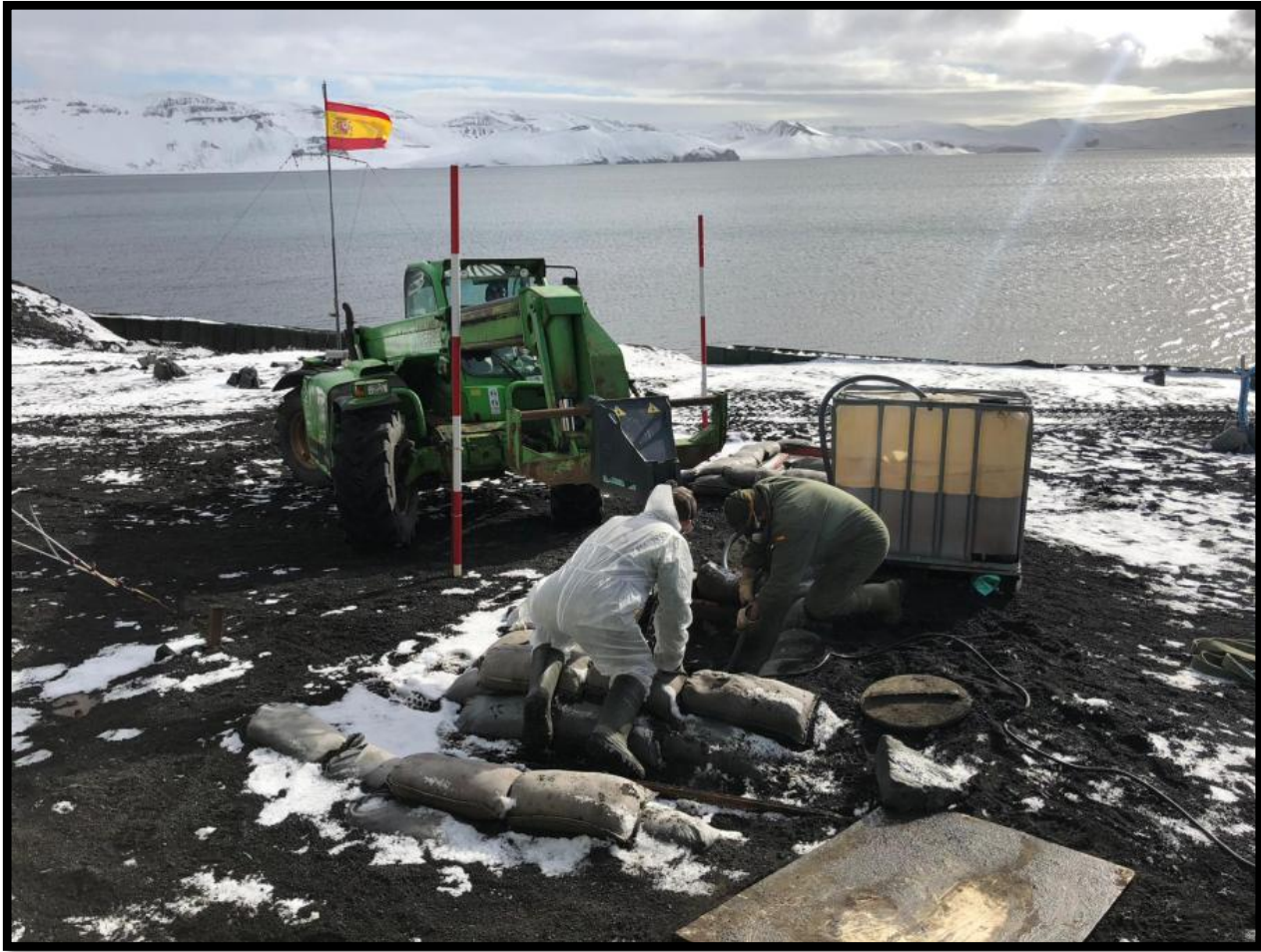
Vaciado de fosas sépticas
