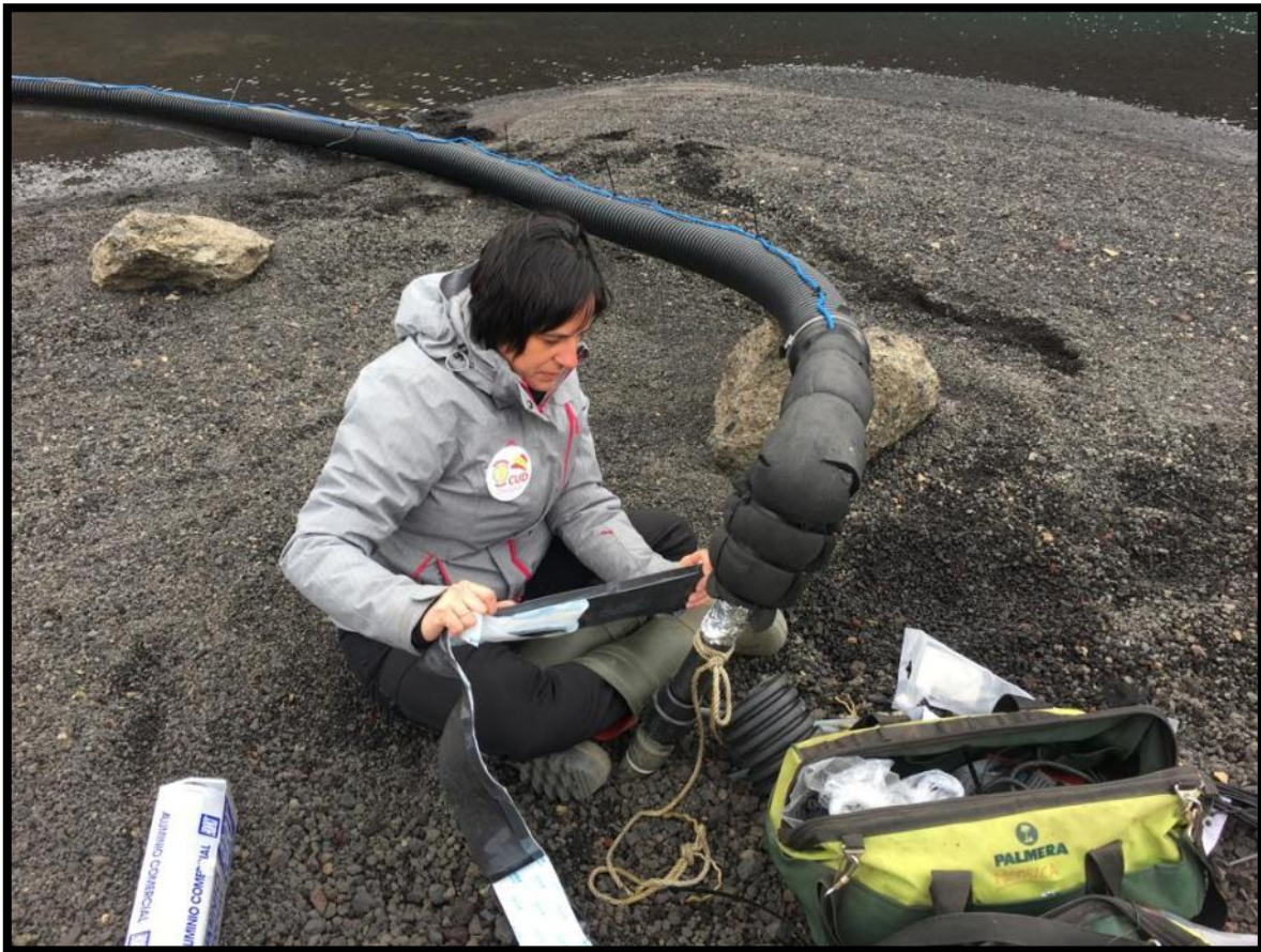
Sellado de final de tramo de tubería
