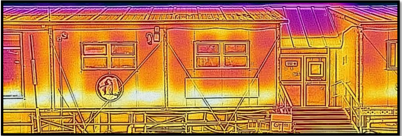
Termografía general del módulo de habitabilidad
