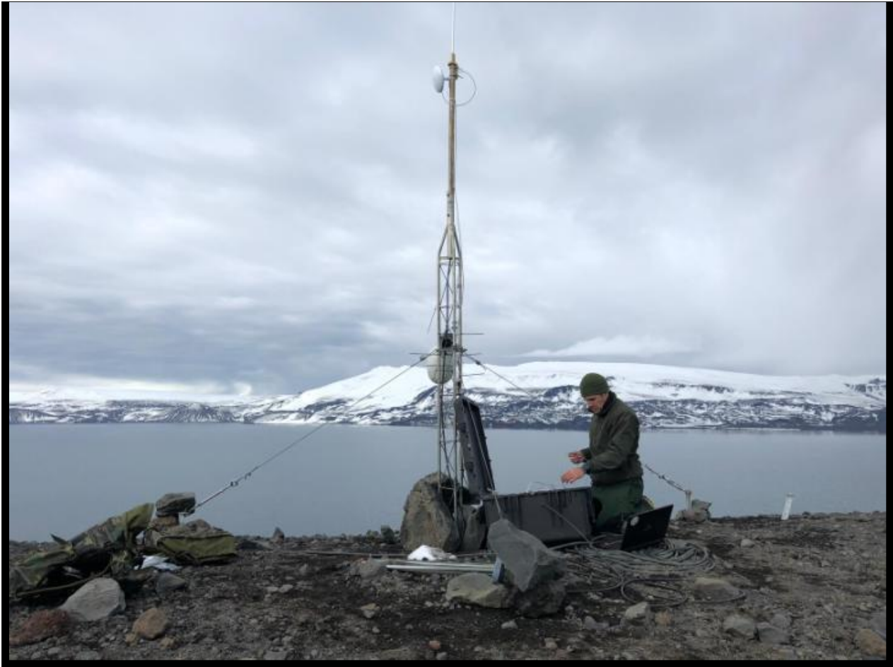
Instalación de aparatos de telecomunicaciones en Vértice Baliza
