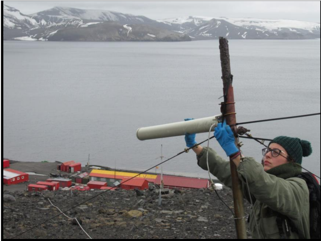
Trabajos de mantenimiento de la antena wifi de BEGC
