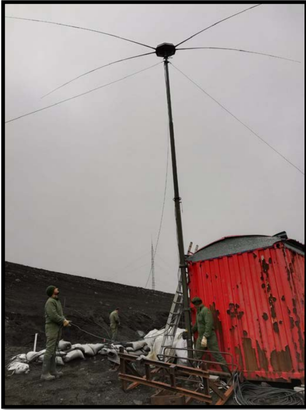
Desmontaje de la antena de HF
