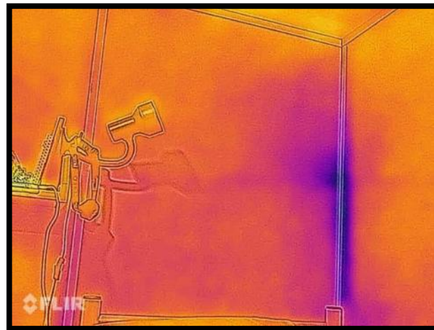
Termografías del módulo de habitaciones
