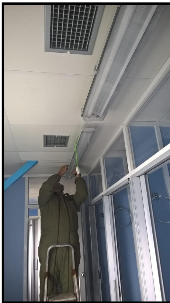
Sustitución de luminaria
