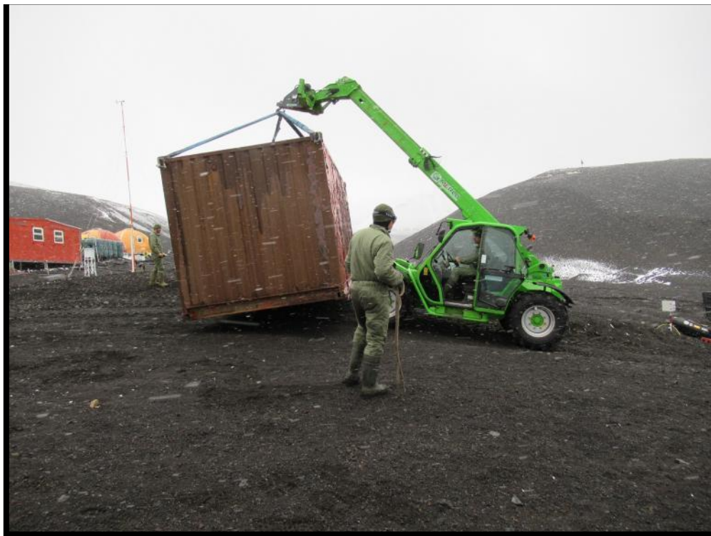
Extracción del contenedor antiguo
