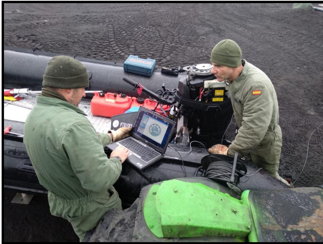
Reparación de un motor de una embarcación
