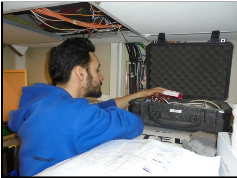
Instalación de la estación sísmica de invernada de la BAE
