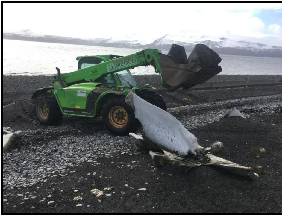
Colocación de grandes rocas para la protección de la rampa
