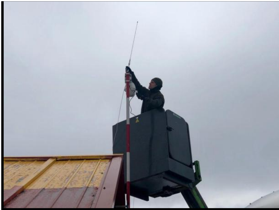
Instalación de repetidores de telecomunicaciones en la base
