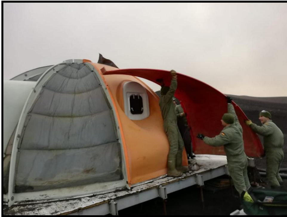
Inicio de desmontaje del segundo iglú
