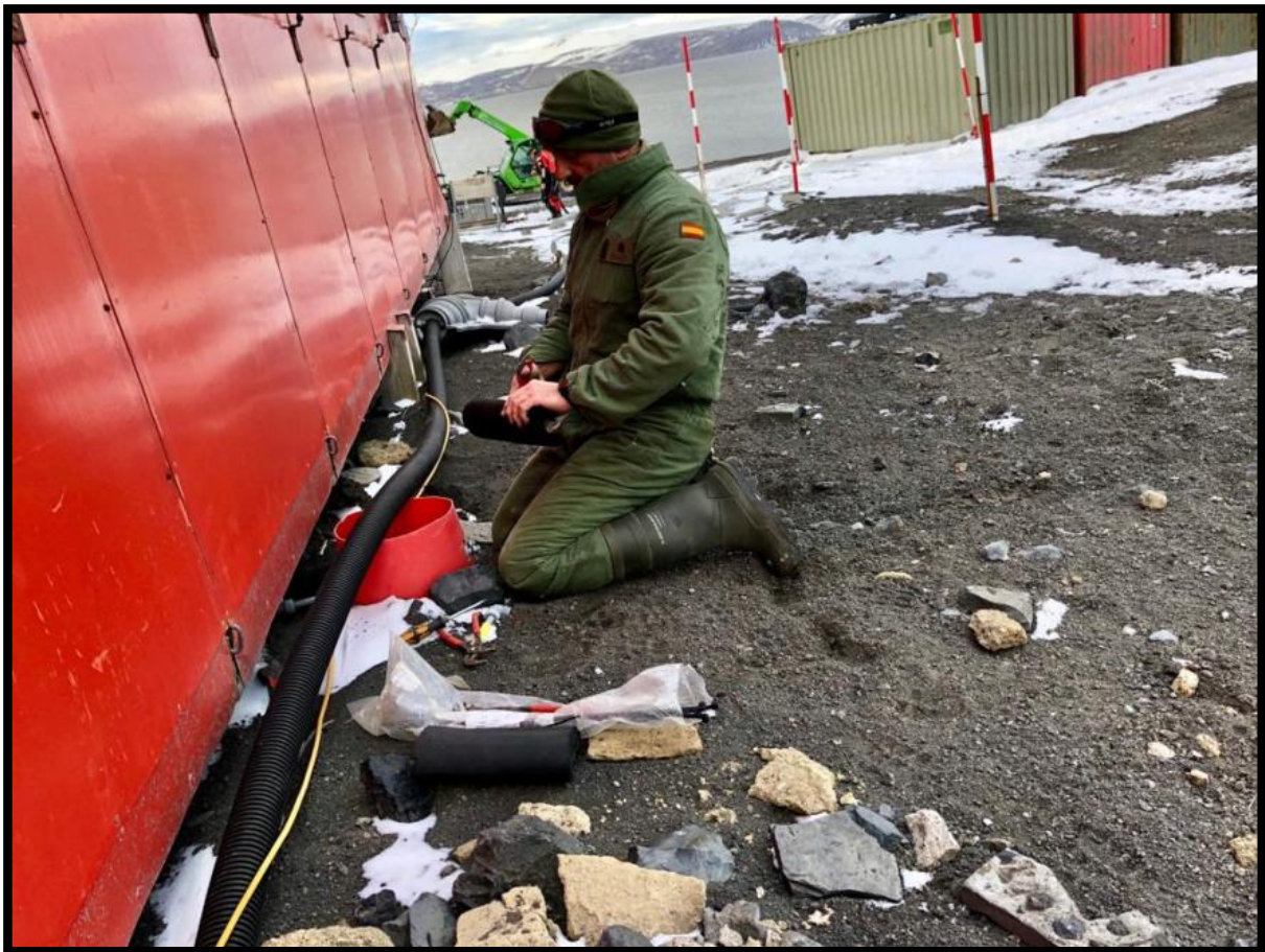
Reparación de la red secundaria de abastecimiento de agua
