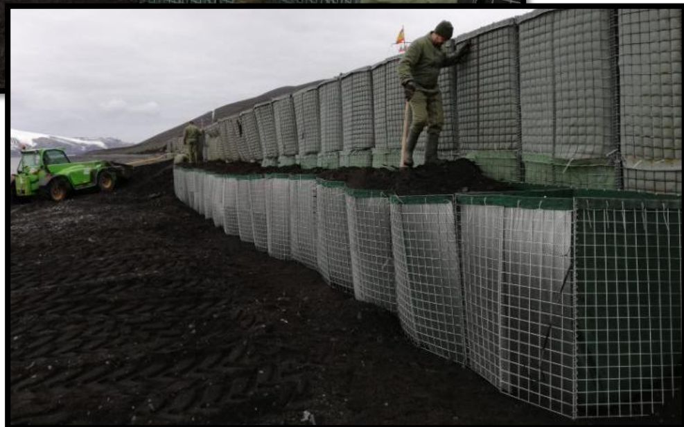
Proceso de cambio de las protecciones del frente de playa
