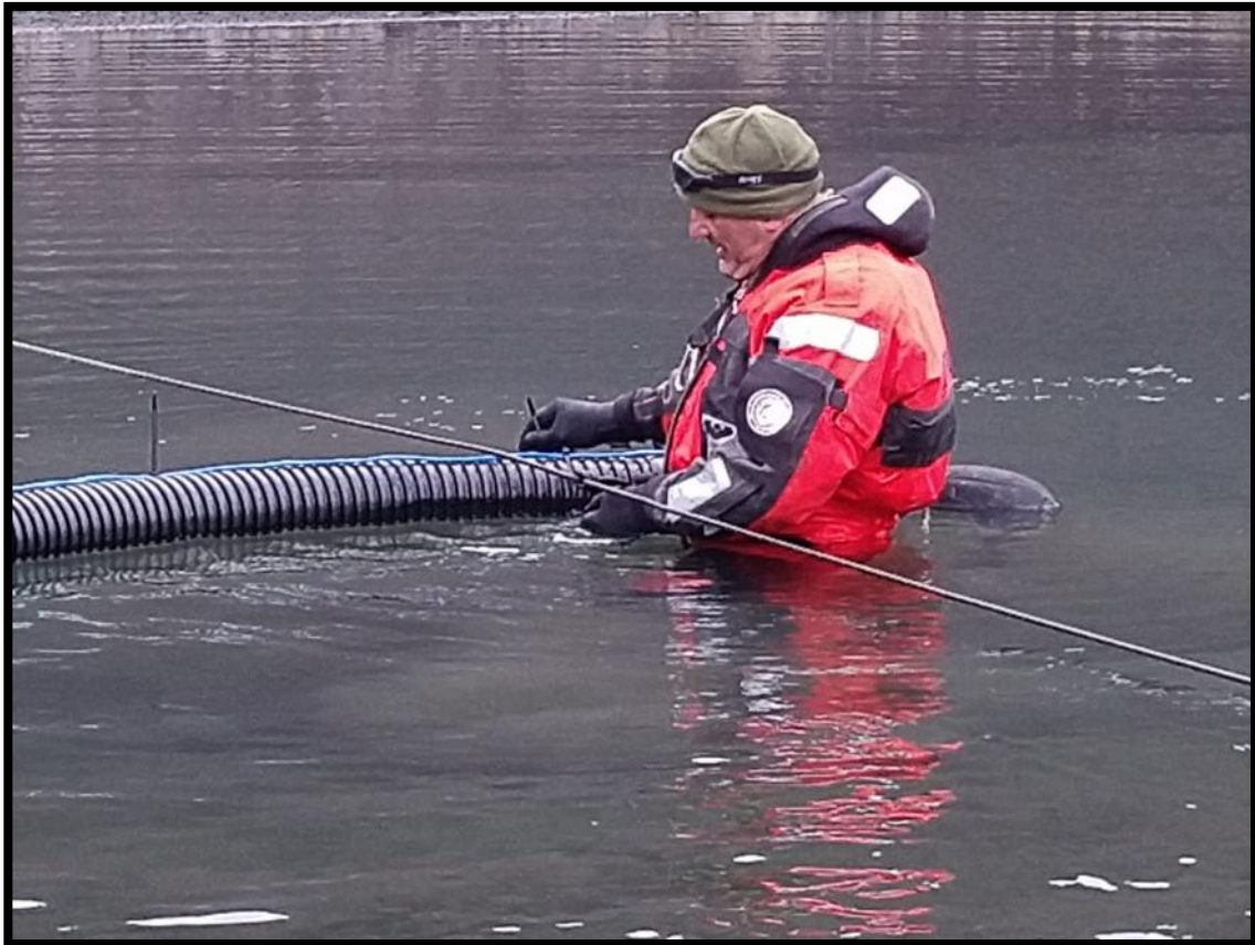
Pruebas de calefacción del último tramo de la tubería
