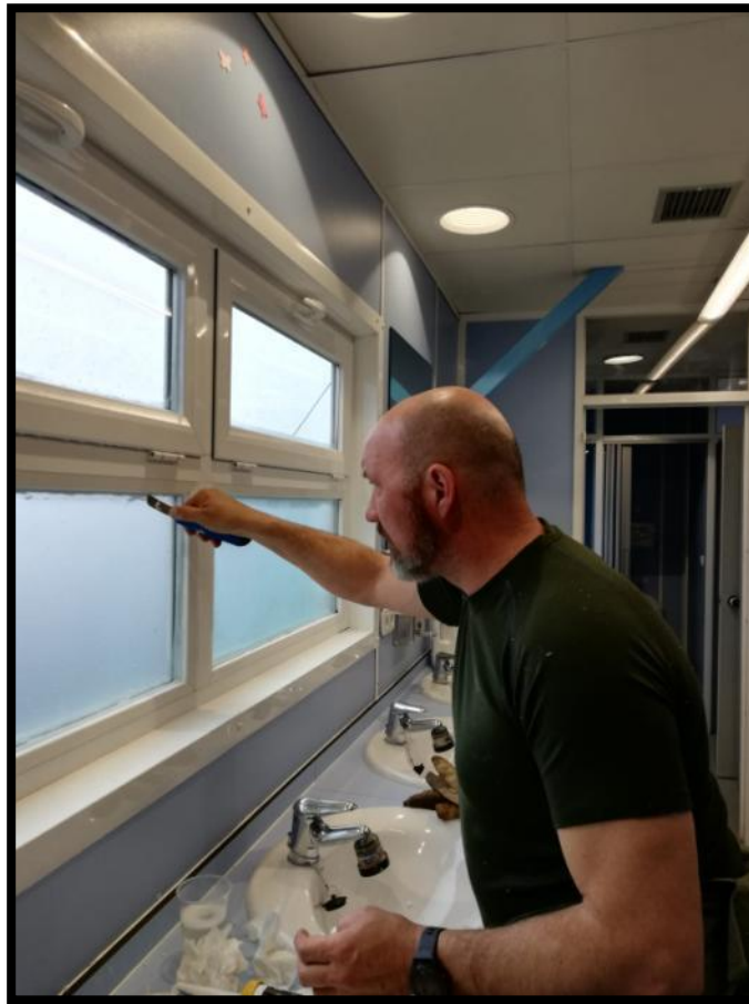
Mantenimiento de ventanas
