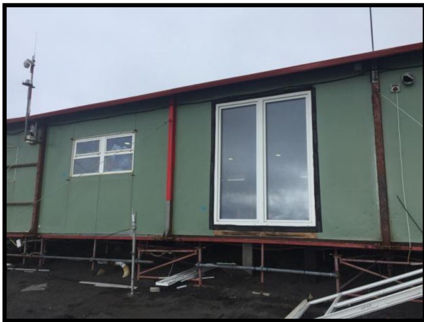
Proceso de sustitución de un ventanal
