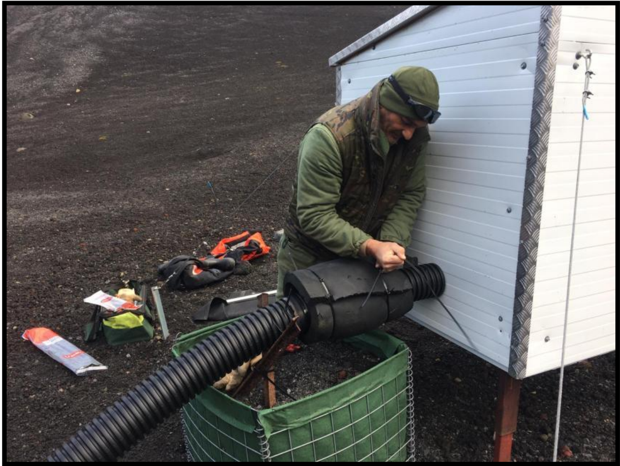
Preparación del sistema de abastecimiento de agua para el frío
