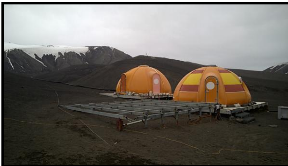
Proceso de desmontaje
