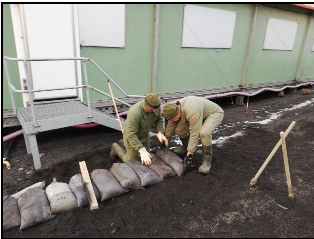
Colocación de contenedores del terreno
