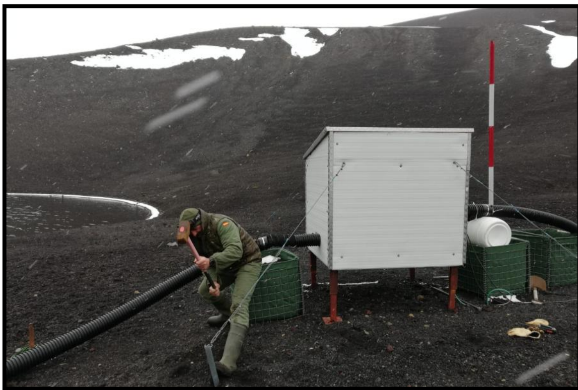
Mantenimiento en la bomba de agua en el Cráter Zapatilla
