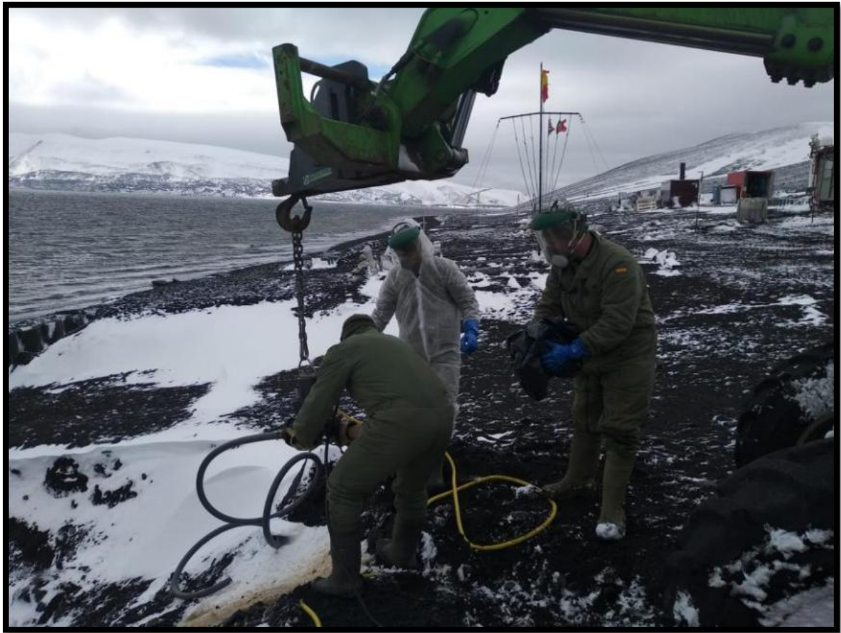
Vaciado de las fosas sépticas y decantadores
