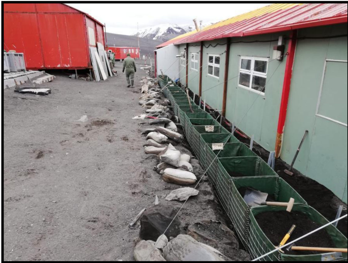
Imagen del proceso de colocación
