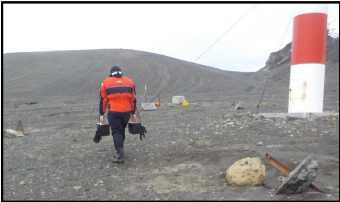
Cambio de baterías del array realizado esta mañana
