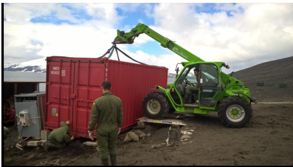
Colocación del segundo contenedor nuevo
