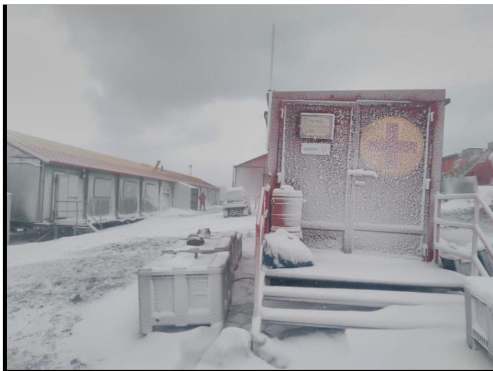
Vista del botiquín durante el temporal
