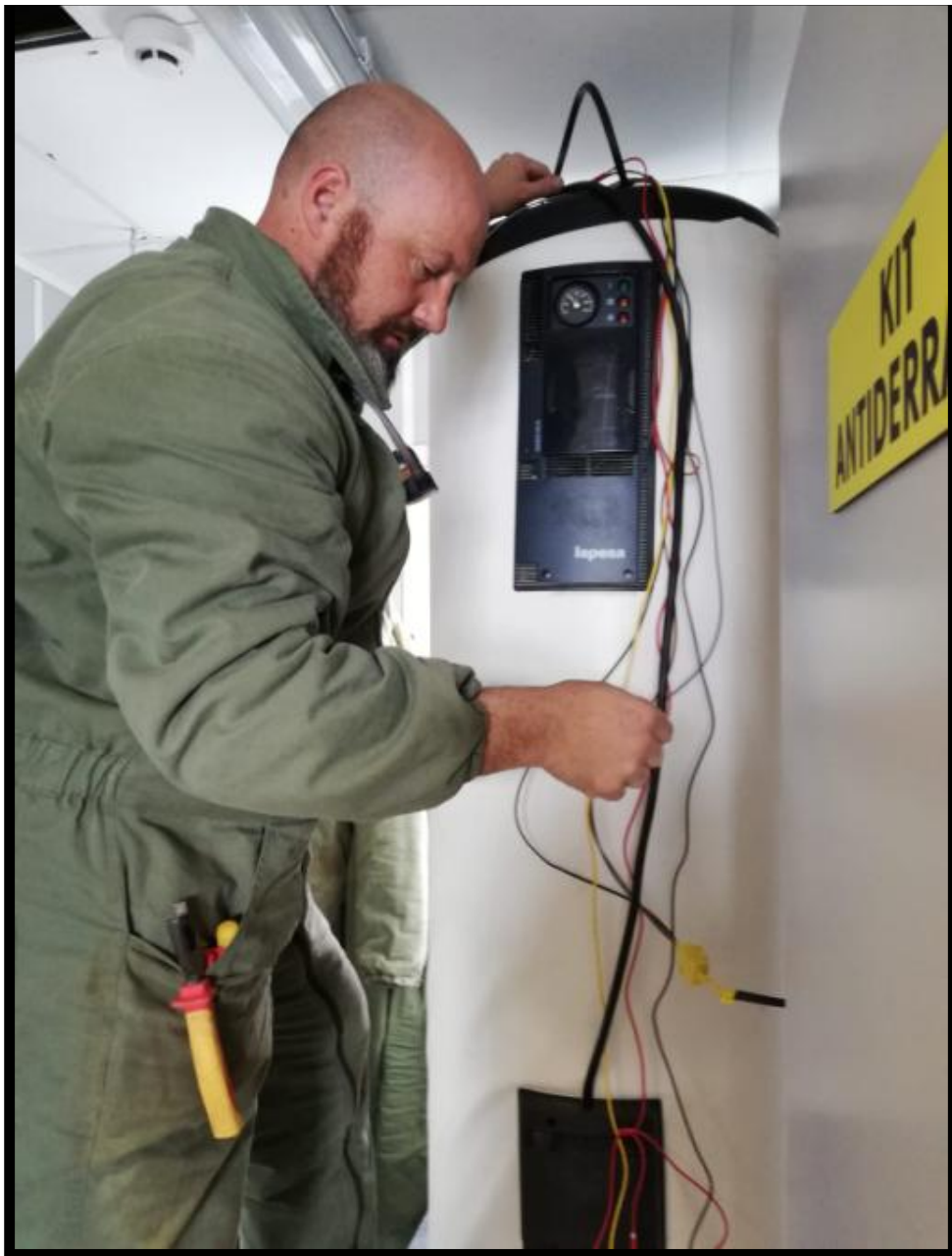
Instalación de analizador de redes
