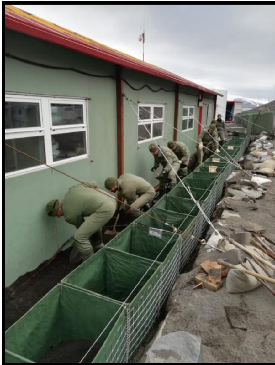
Trabajos de contención de la ladera
