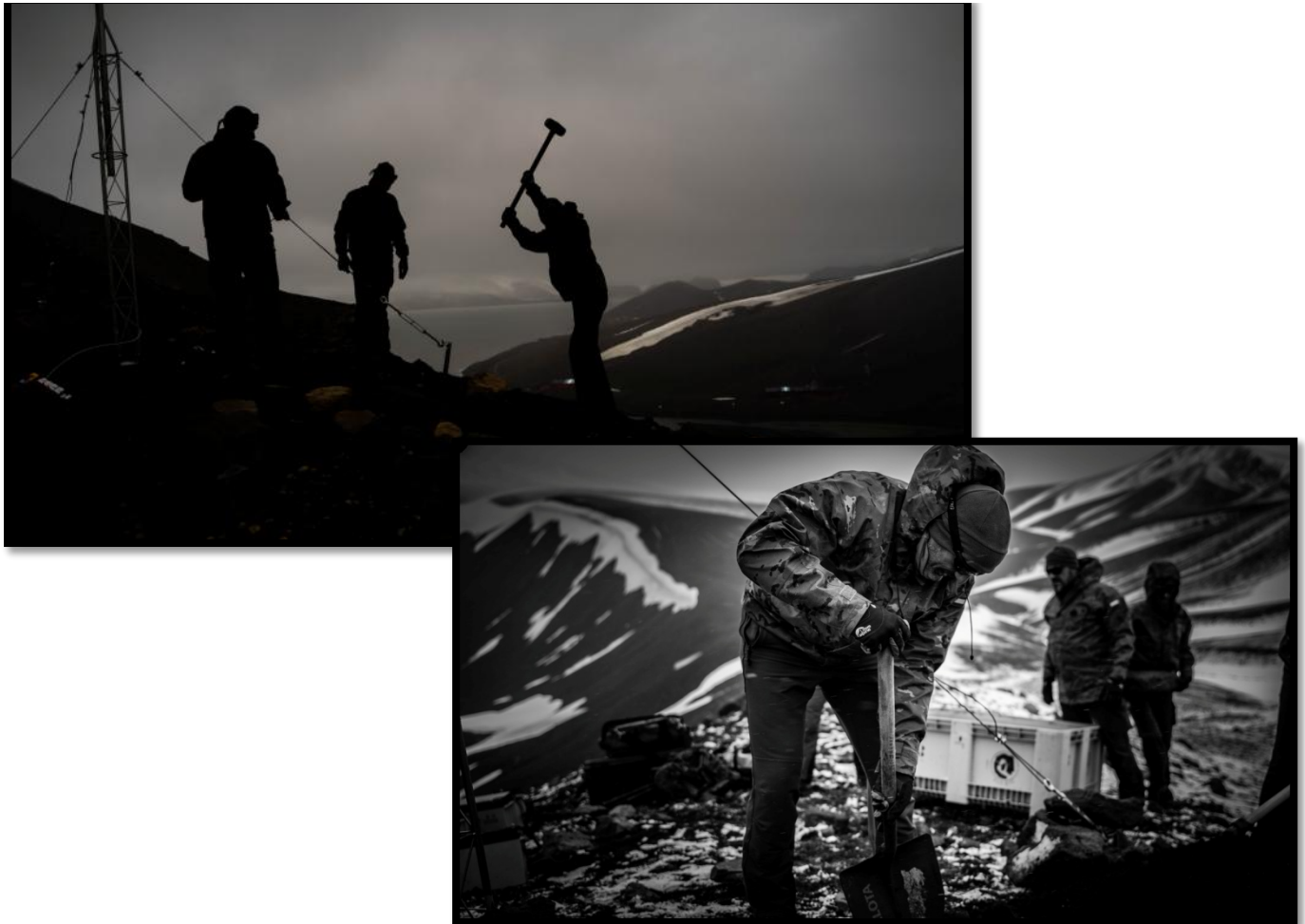
Trabajos de anclaje de la estructura que soporta los sistemas
