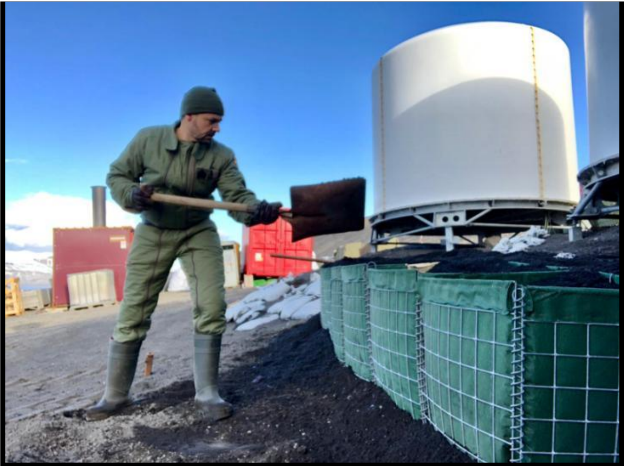
Mejora de la estabilidad del terreno circundante a los terminales satélite
