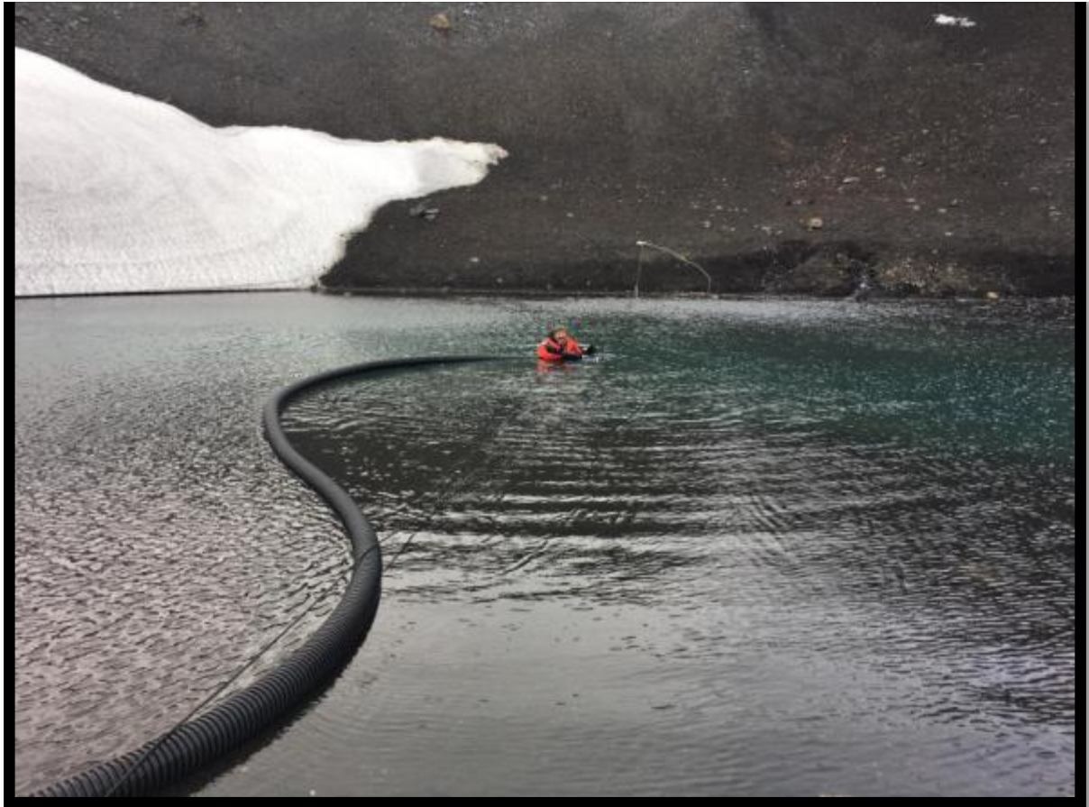
Comprobación de la bomba de agua sumergida en el cráter Zapatilla
