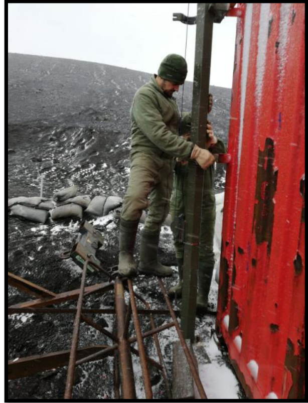
Desmontaje de la antena de HF
