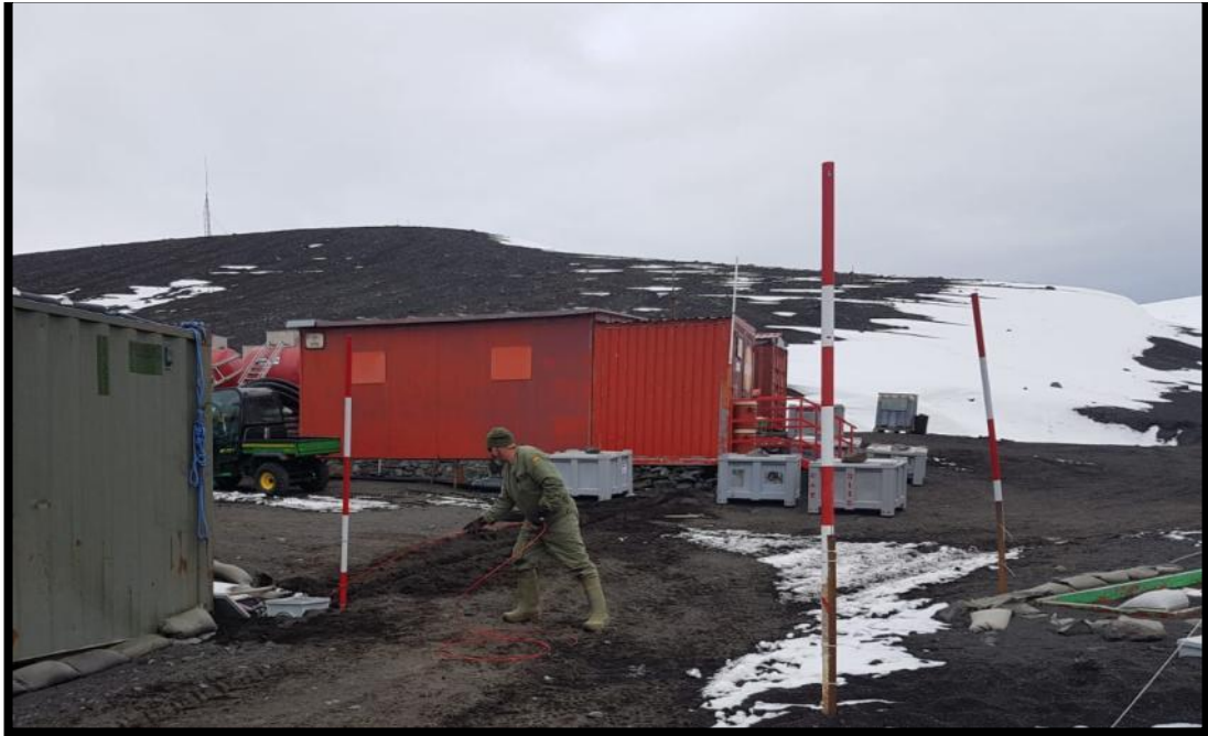
Colocación del cable del sensor contra incendios
