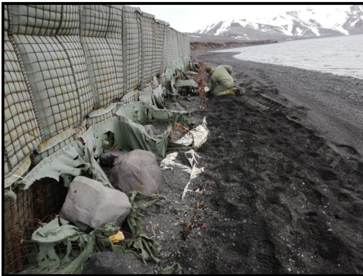
Saneamiento de las protecciones del frente de costa
