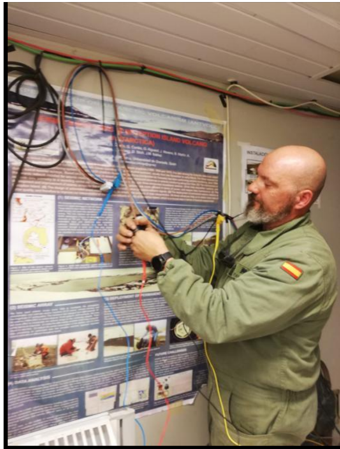
Instalación de analizador de redes
