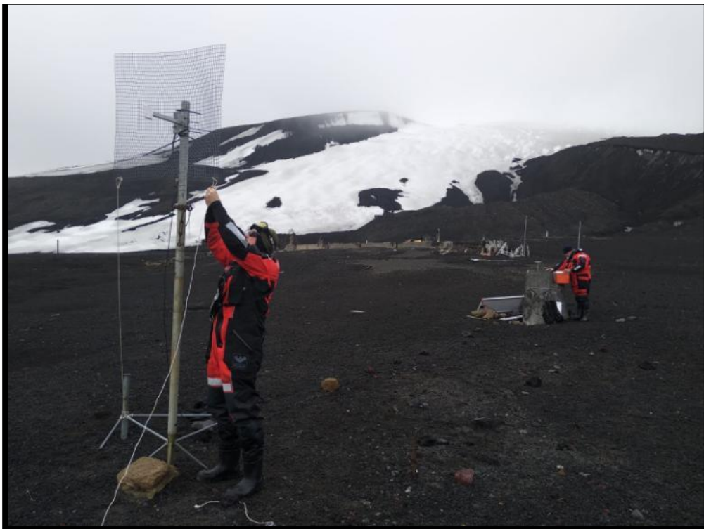
Revisión de la instalación wifi de caleta Péndulo
