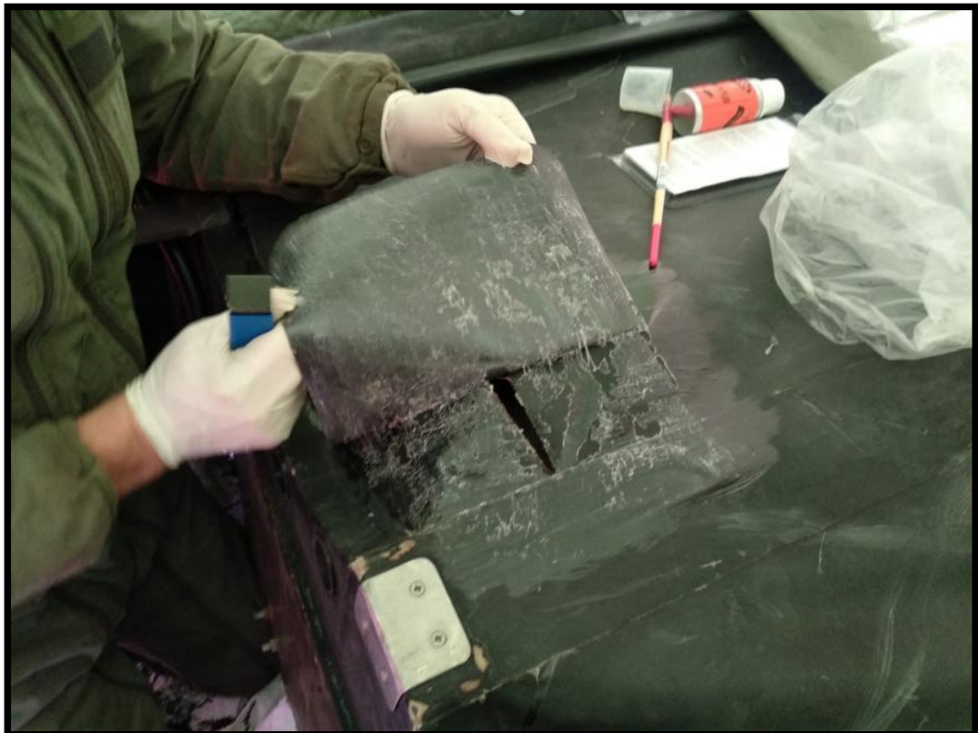
Proceso de reparación
