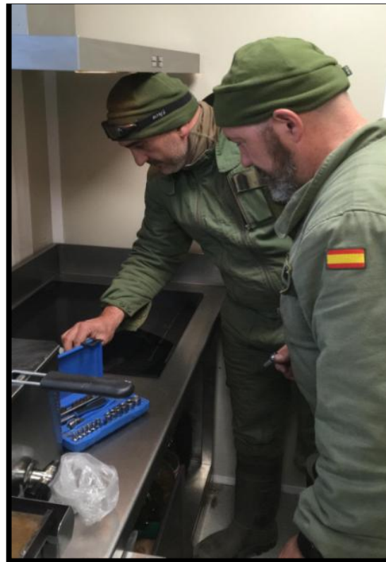
Colocación de la nueva encimera de la cocina
