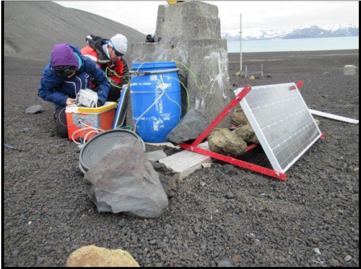
Colocación de uno de los sistemas GPS
