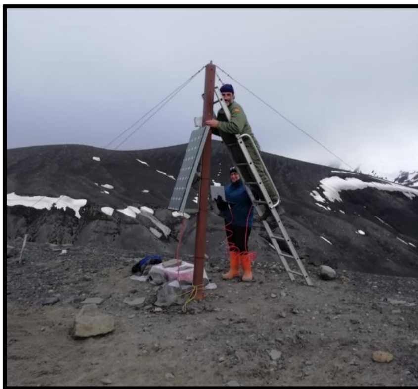
Instalación finalizada de la cámara situada junto a la estación DCP
