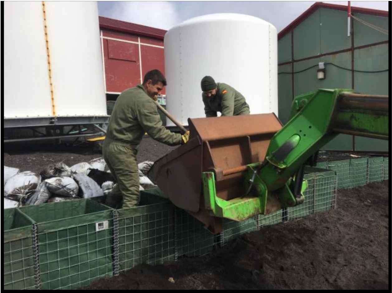
Firme del terreno, para asentar los Radomos de Comunicaciones Satelite
