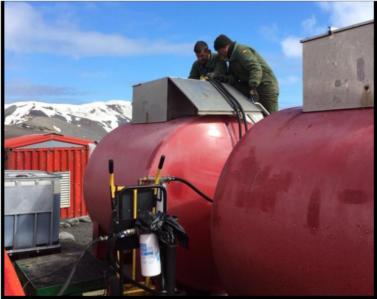
Verificación y trasvase de combustible
