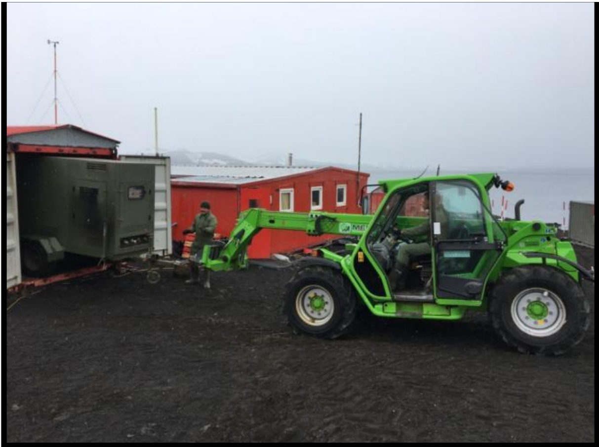
Proceso de preparación del generador para su transporte marítimo
