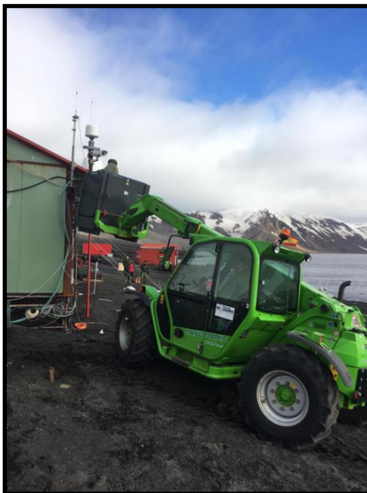
Desmontaje de elementos
