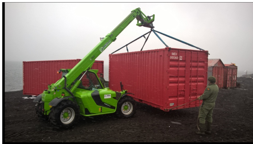
Detalle de la colocación contenedor nuevo
