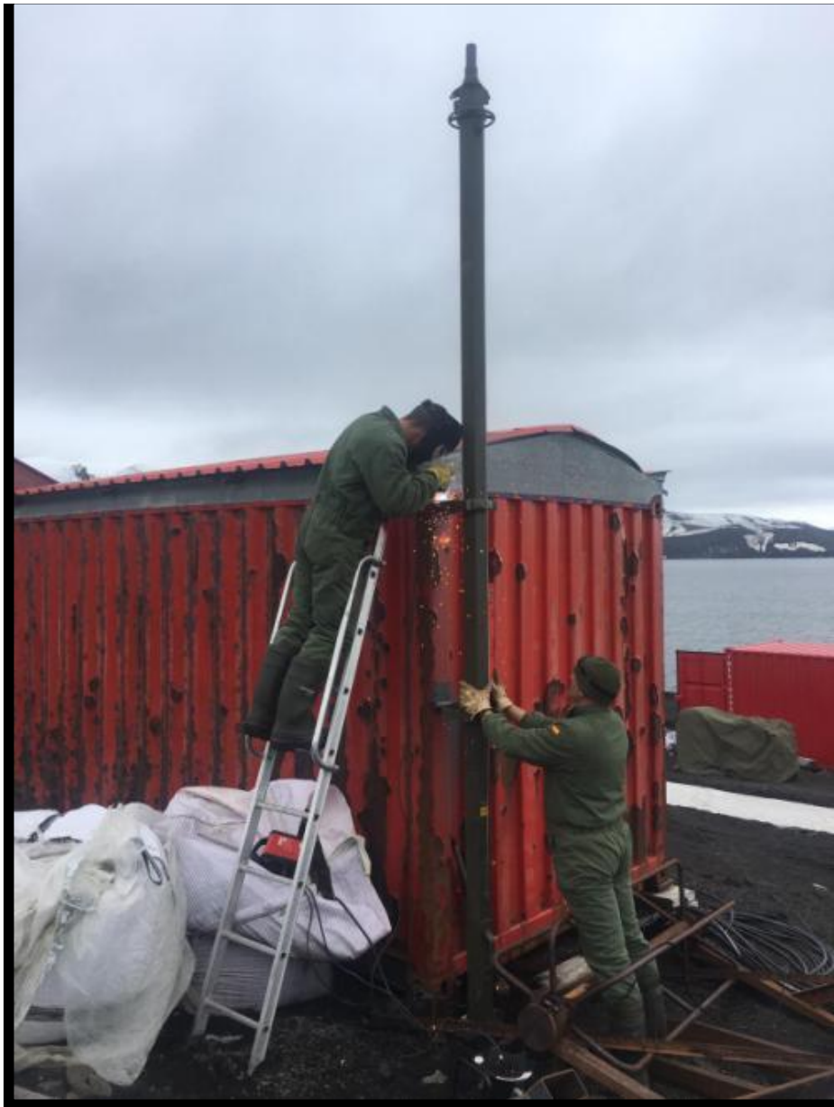
Inicio de instalación del mástil que albergará la antena de HF
