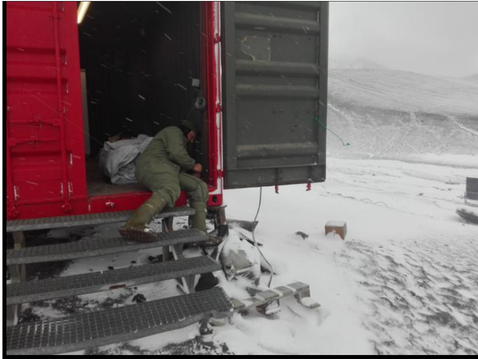
Colocación de conexiones eléctricas en un contenedor nuevo
