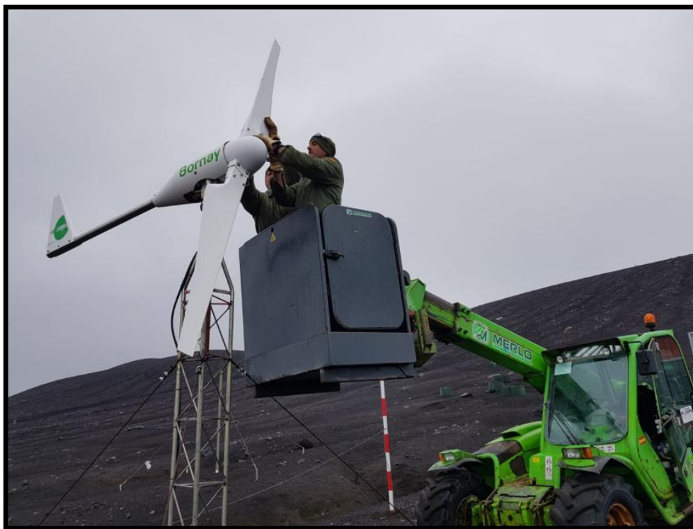
Mantenimiento del aerogenerador
