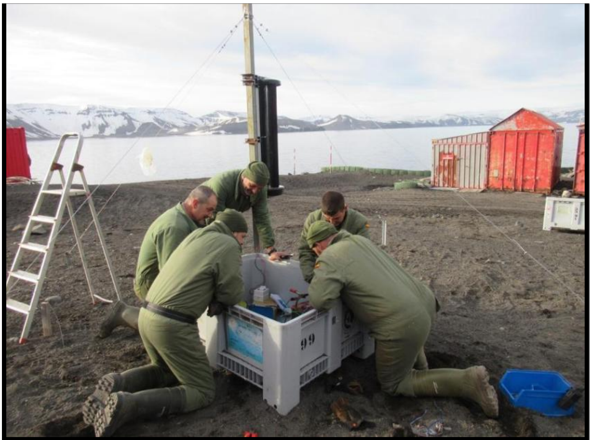
Pruebas iniciales al generador en clima extremo
