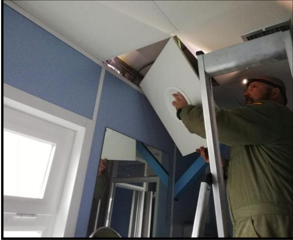
Cambio de parte del techo del baño
