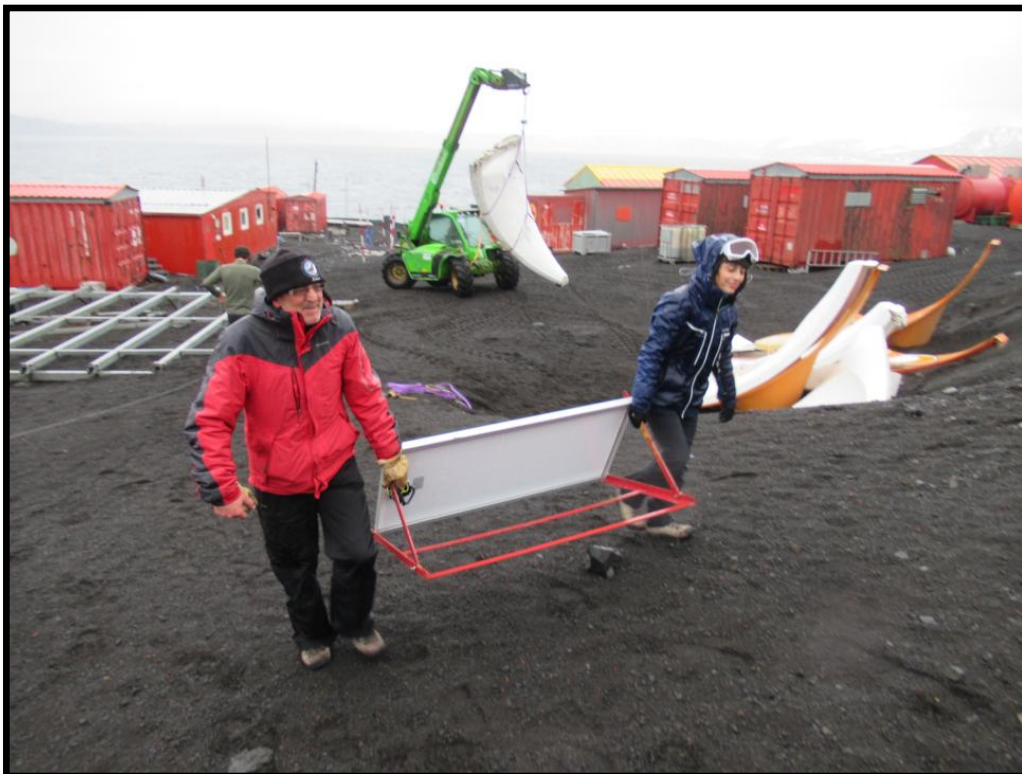
Subida de los paneles solares a la estación BEGC
