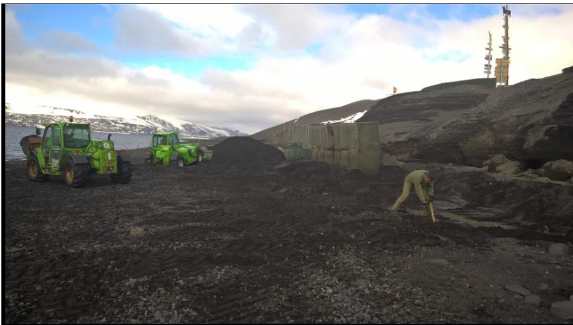
Trabajos de protección de la playa
