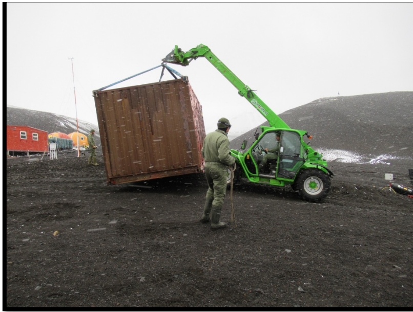
Detalle del contenedor antiguo
