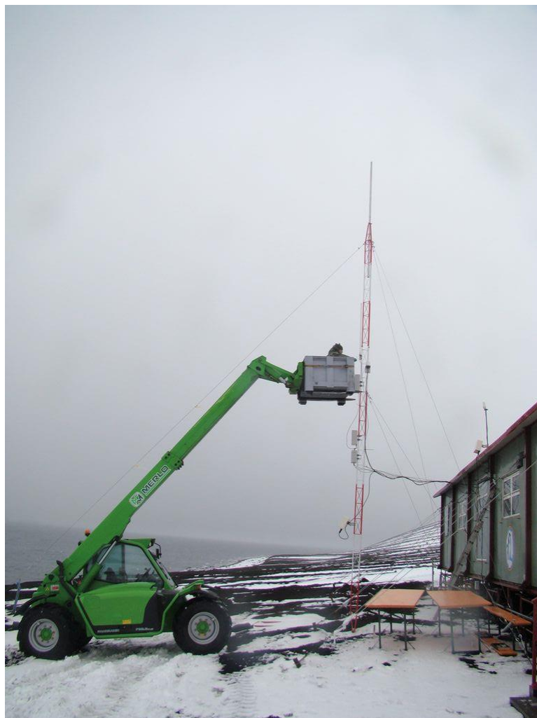
Desmontaje de sistemas de telecomunicaciones.
