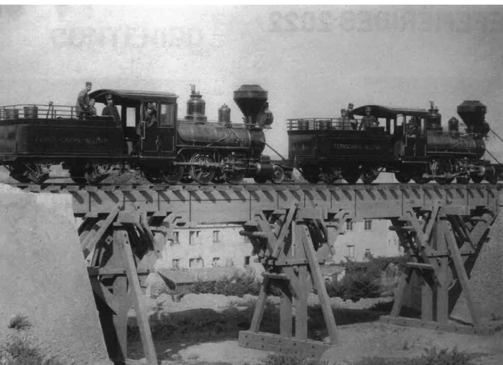
Escuelas prácticas del Batallón de Ferrocarriles en terrenos aledaños al Cuartel de la Montaña. La foto corresponde a dos locomotoras 1-3-0 en dotación desde 1895
