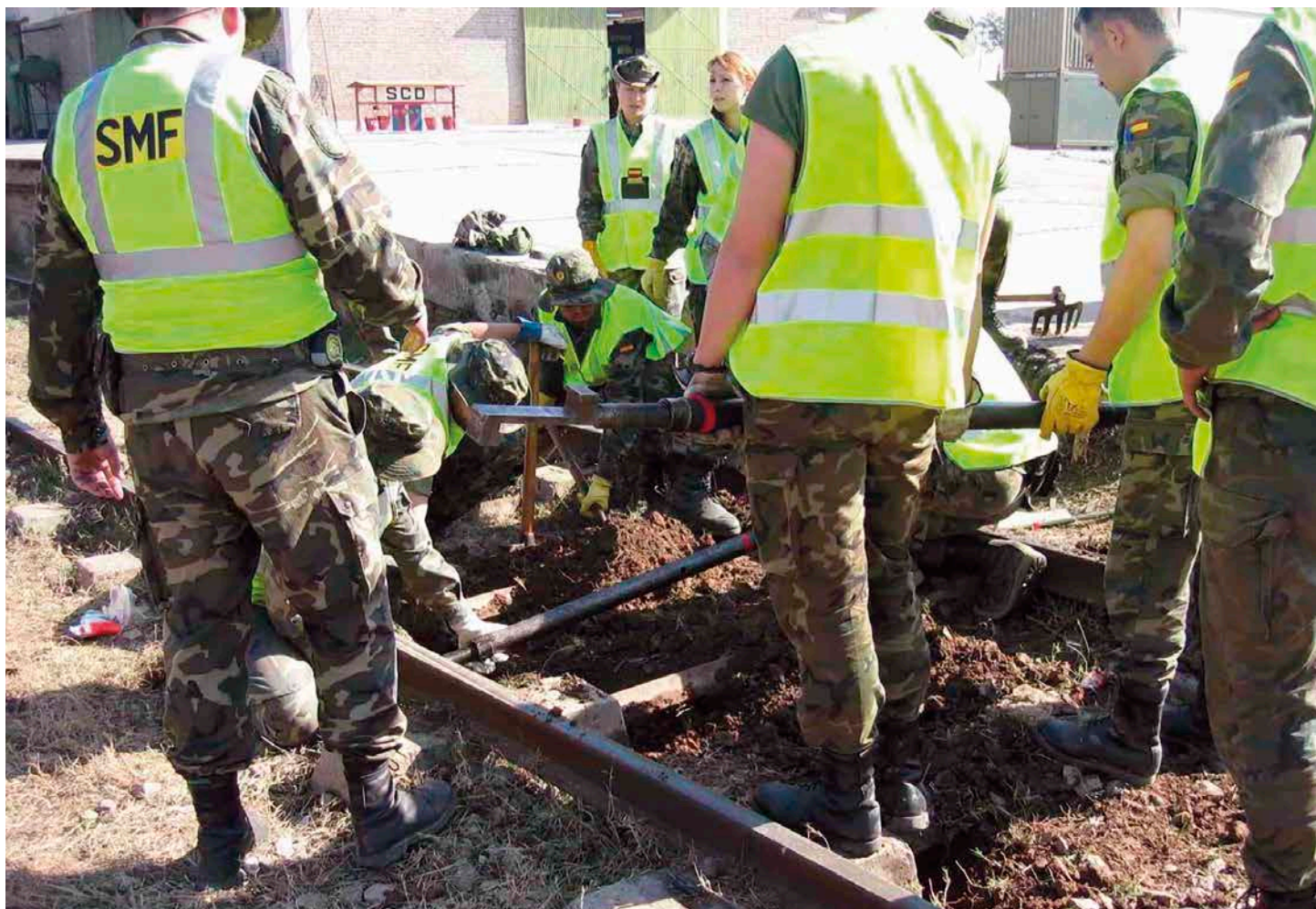
Rehabilitación de infraestructura ferroviaria
