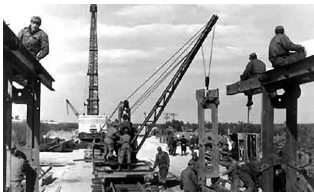
Premontaje del puente FFCC HG
