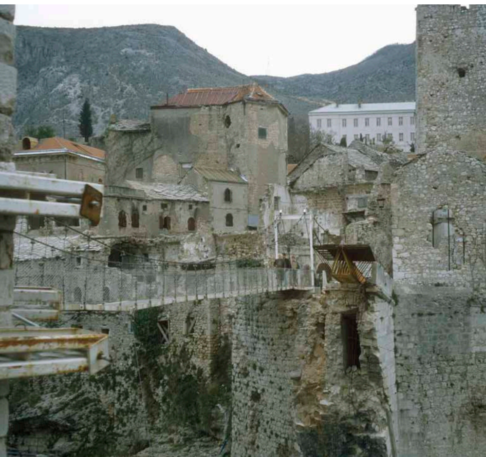
Pasarela temporal sobre el río Neretva (Móstar)
