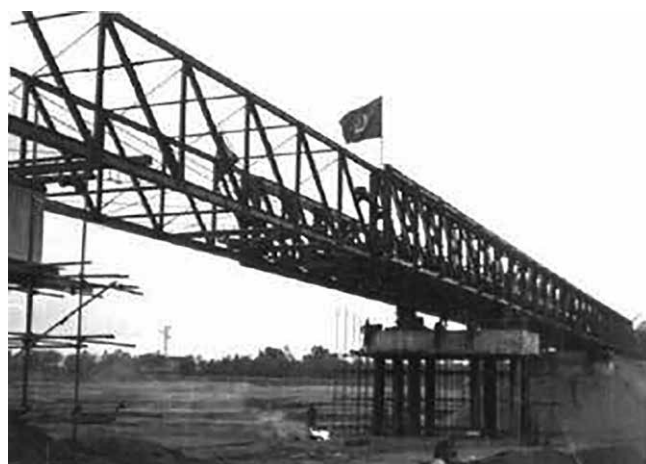
Lanzamiento del puente FFCC HG
