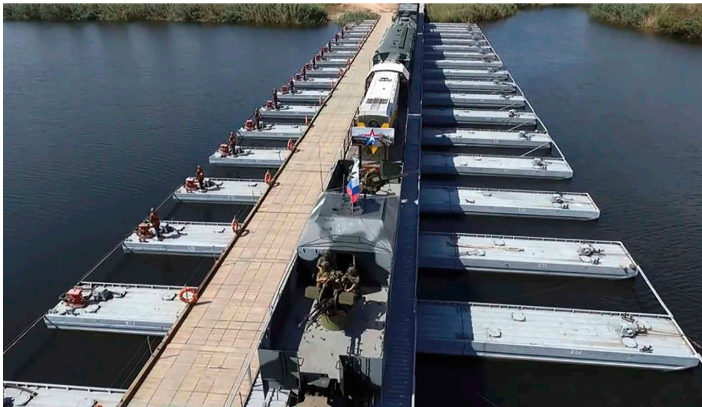
Tren blindado «Baikal» del Ejército ruso atravesando un puente de ferrocarril sobre pontones. Fuente: nevskii-bastion.ru
