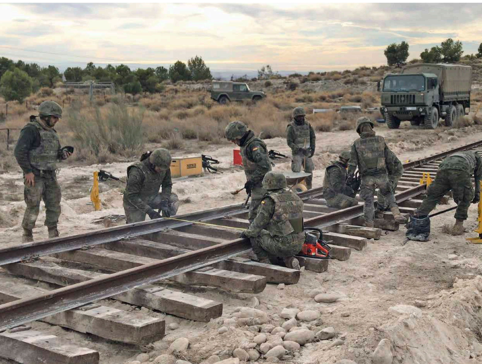
Trabajos de montaje de una terminal ferroviaria en el CENAD San Gregorio (Zaragoza, 2017). Archivo fotográfico del autor
