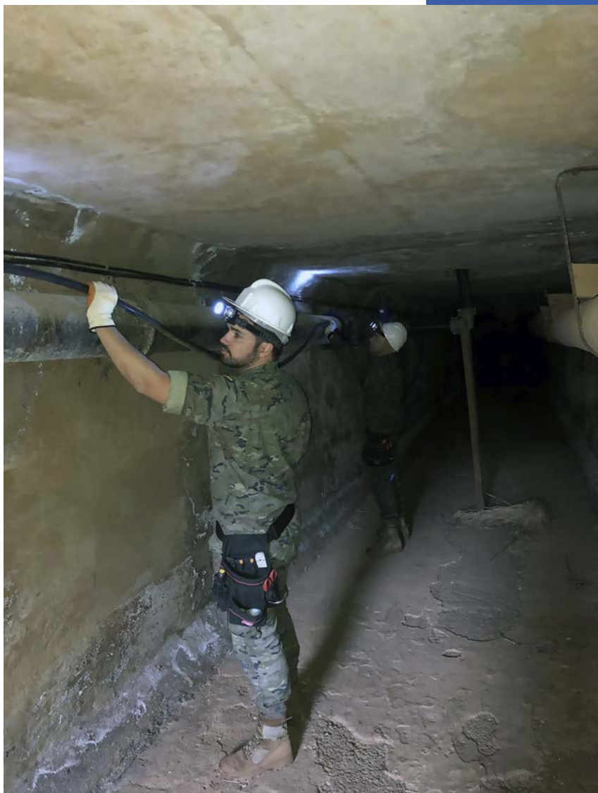
Trabajos de líneas en una galería subterránea
