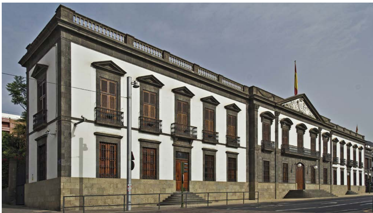
Fachada actual del Palacio de Capitanía
