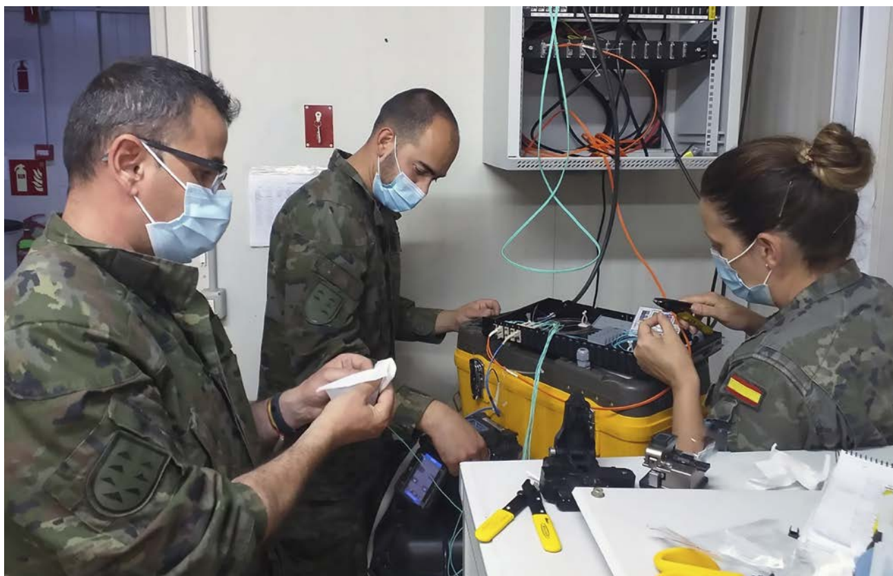
Trabajo de fusonado de fibra óptica
