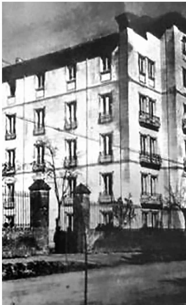
Obras de reforma del Colegio
