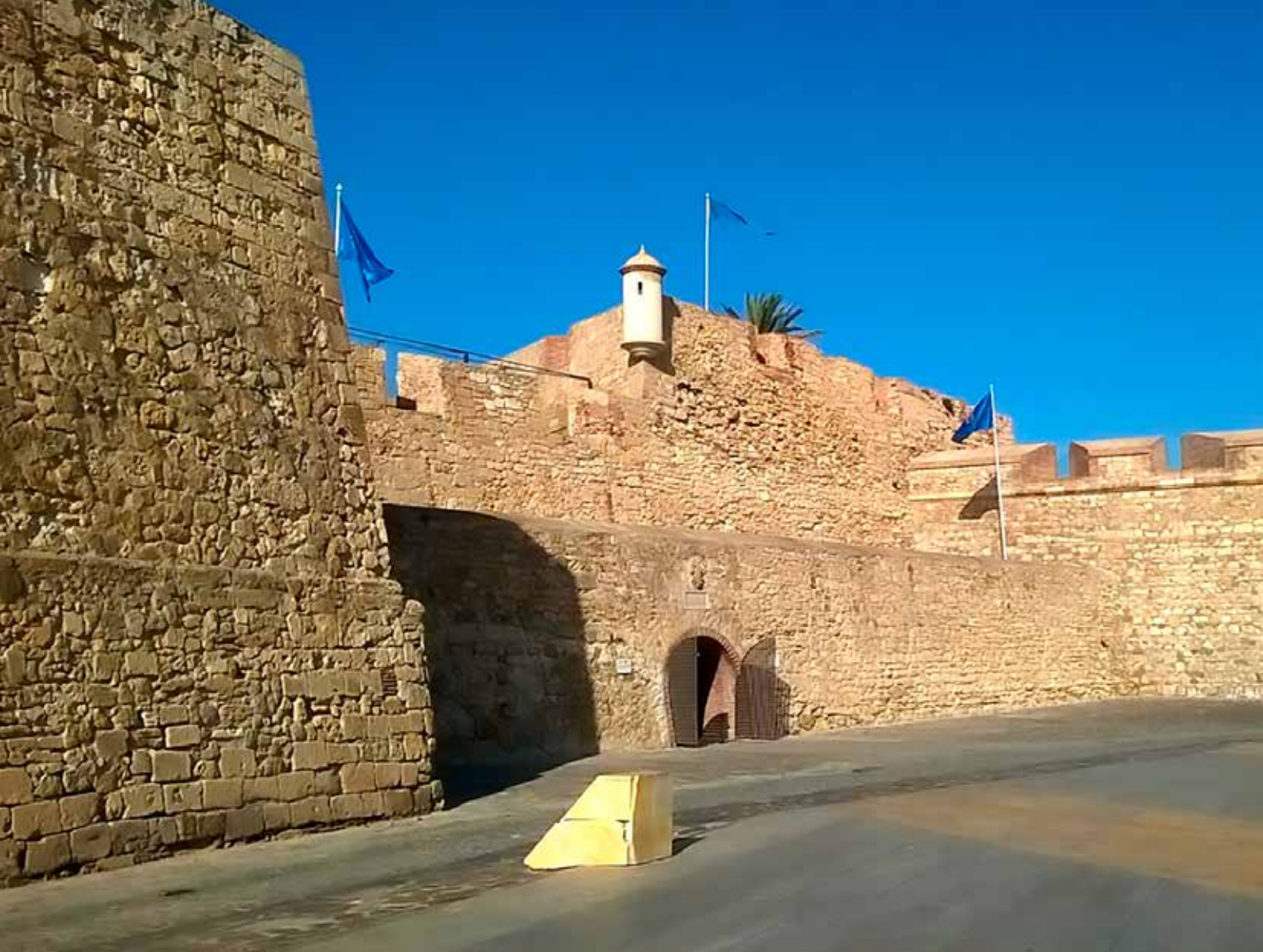
Tercer Recinto. Puerta de San Fernando. 1722. Modelo de fortificación abaluartada
