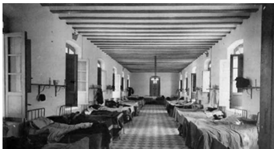
Nave interior del cuartel de enfermería (1895)
