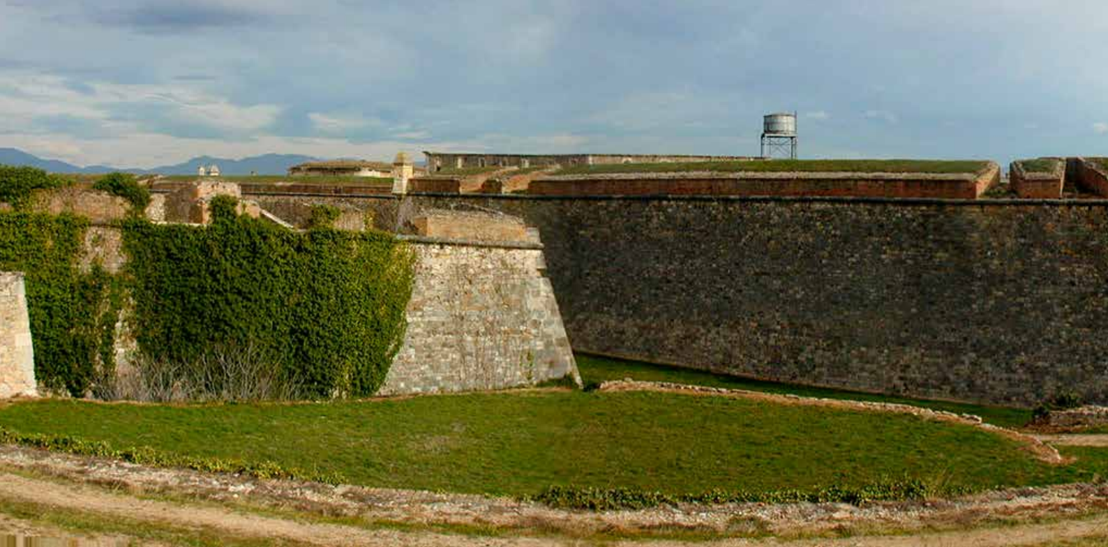
Baluarte de Santa Bárbara
