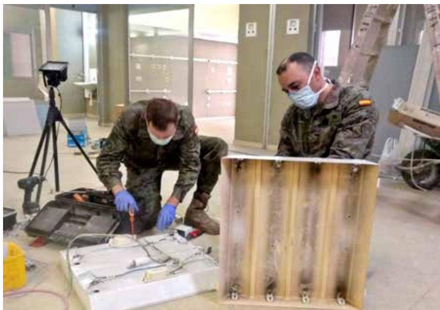
Equipo de Albañilería
