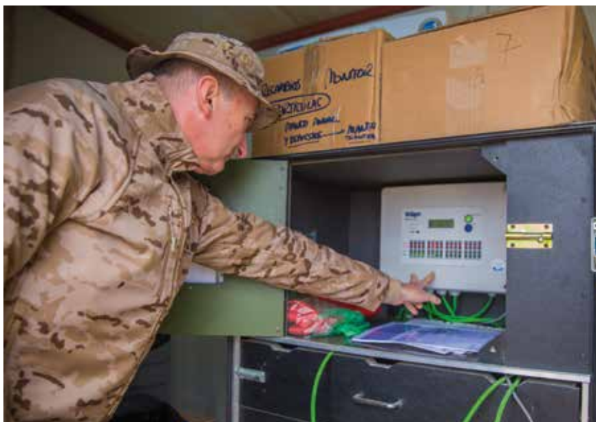
Estación de gases
