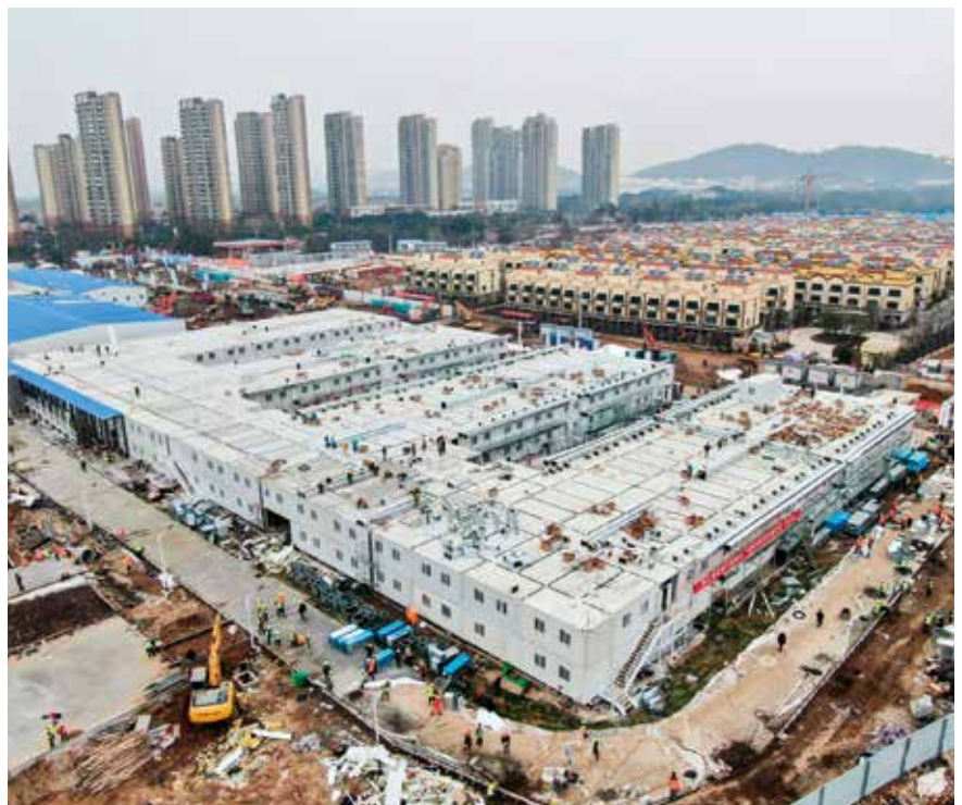
Construcción de un hospital de campaña en Wuhan
