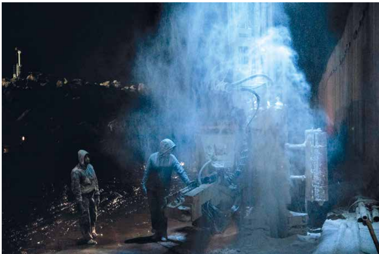
Las perforadoras trabajando sin descanso entre la lluvia y el barro
