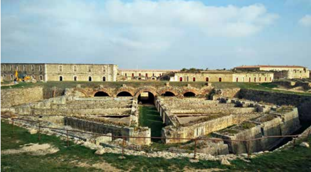
Es necesario continuar con los trabajos de rehabilitación de la Fortaleza
