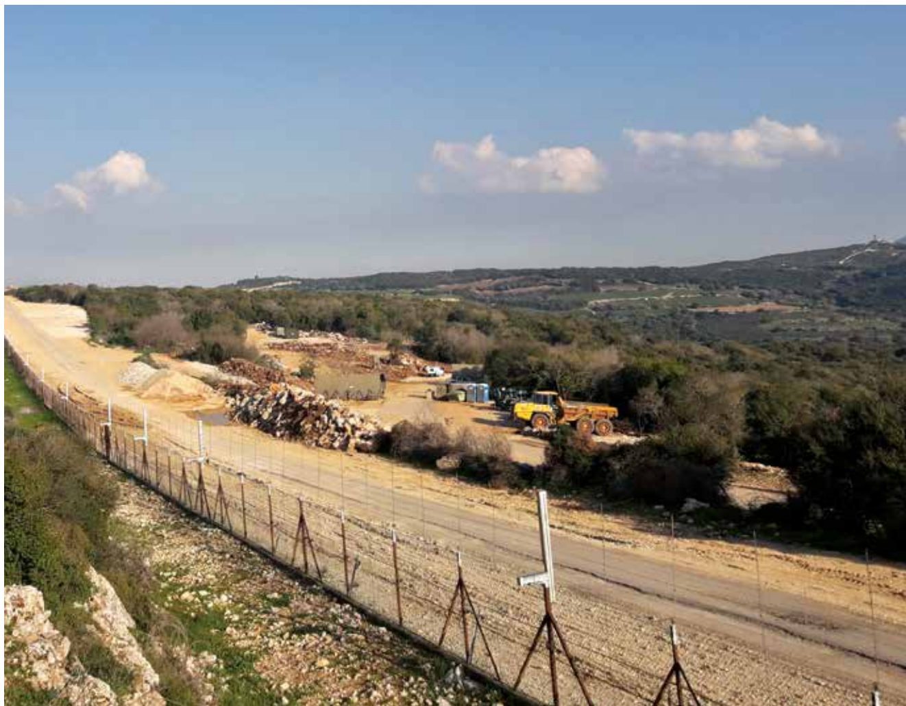
Emplazamiento del sexto túnel
