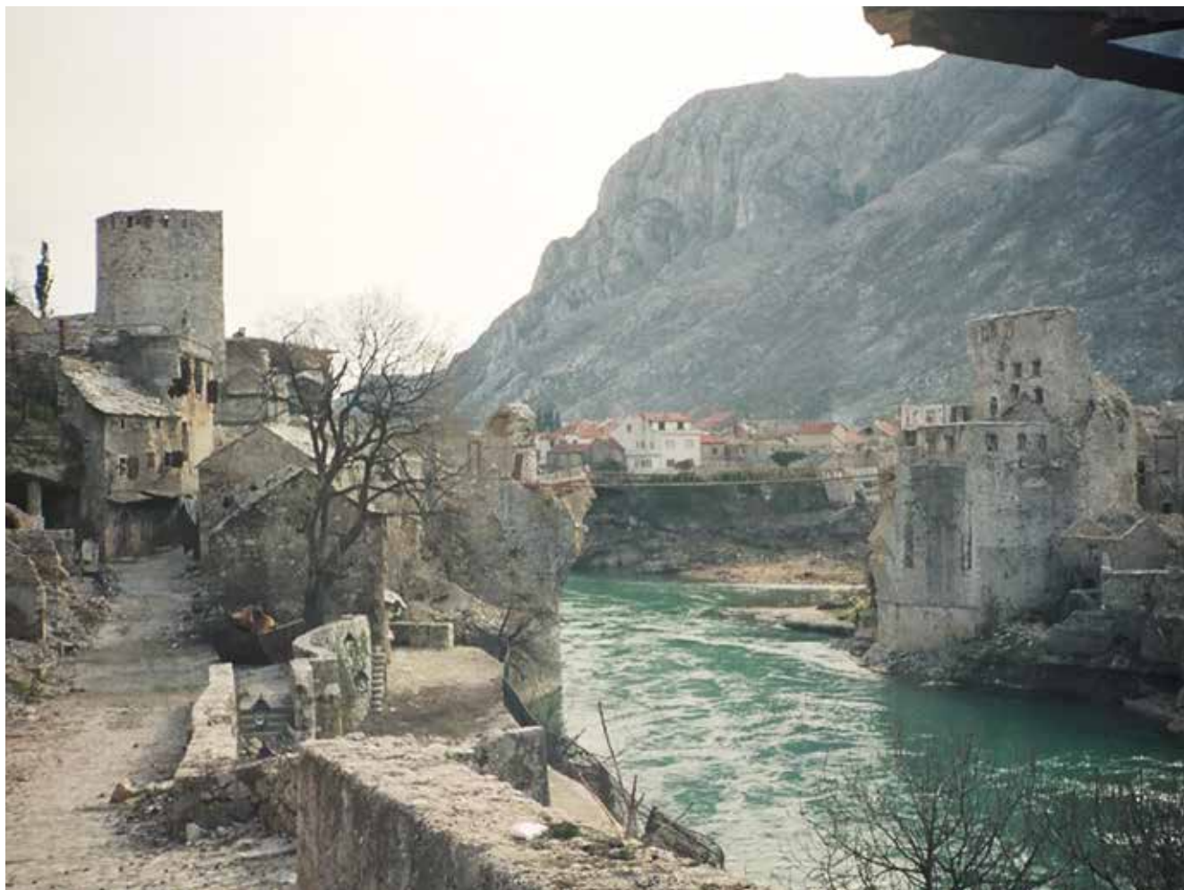
Mostar. Pasarela construida por zapadores españoles sobre el destruido Puente Viejo otomano
