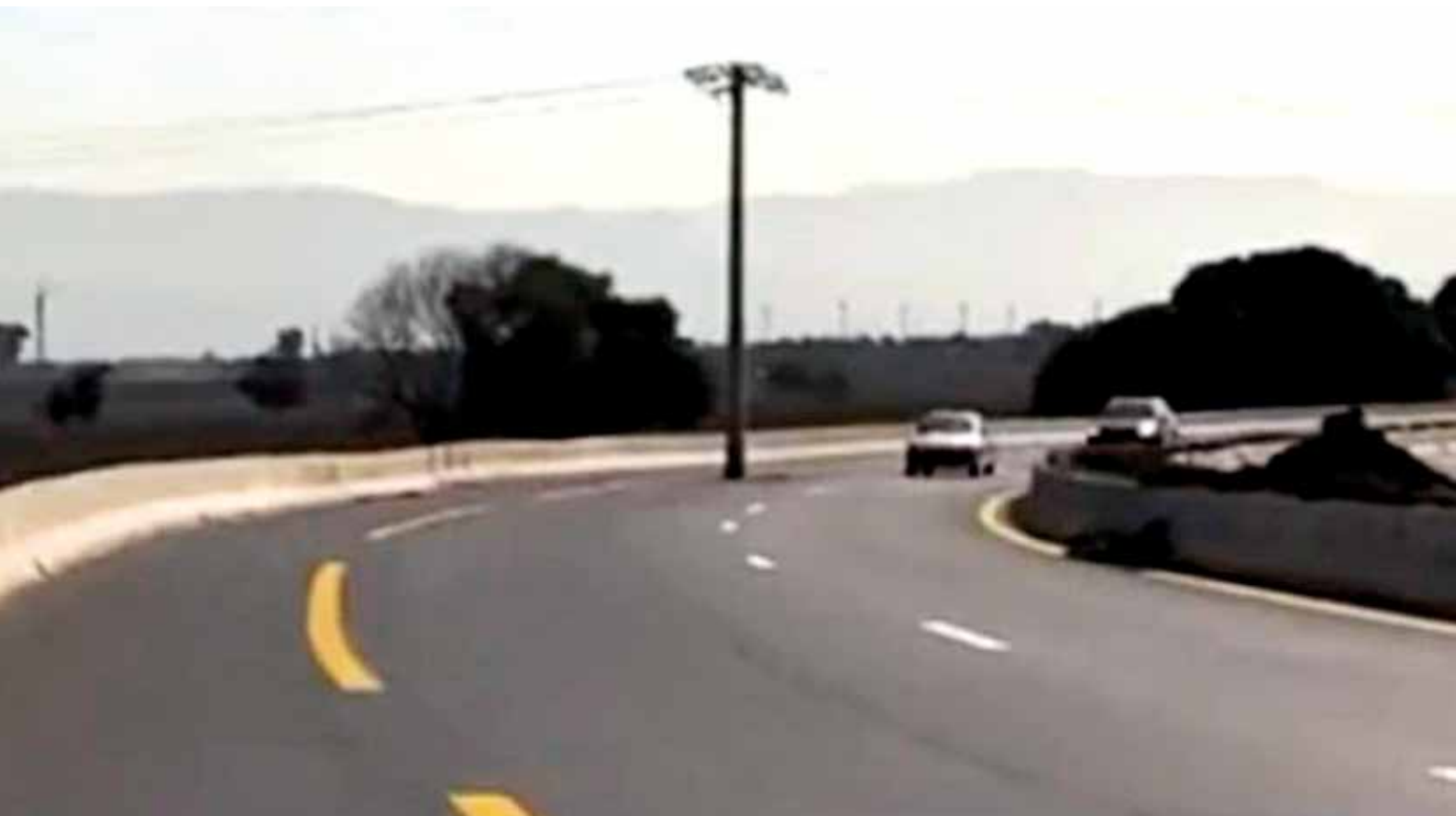
Error de construcción en la autopista cerca de Bab Ali. Argelia necesita sin falta infraestructuras de calidad
