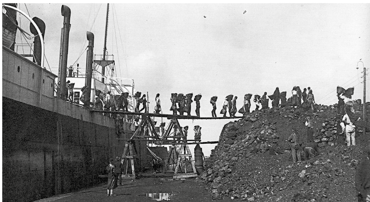
▲ Cargadero de mineral
