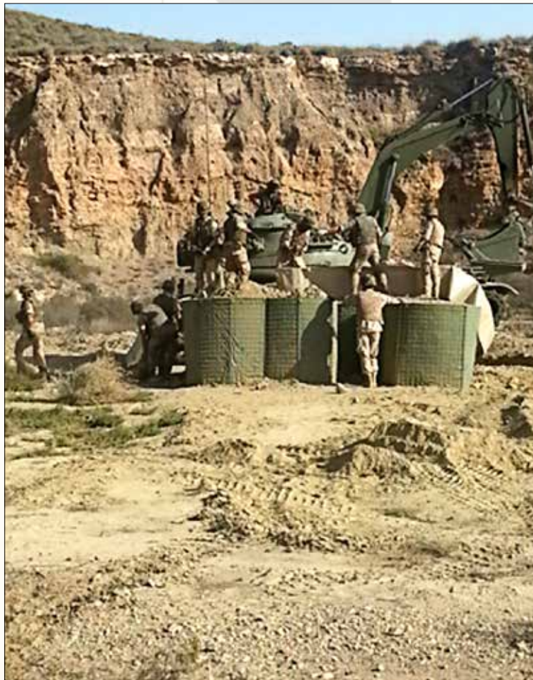
Trabajos de fortificación
