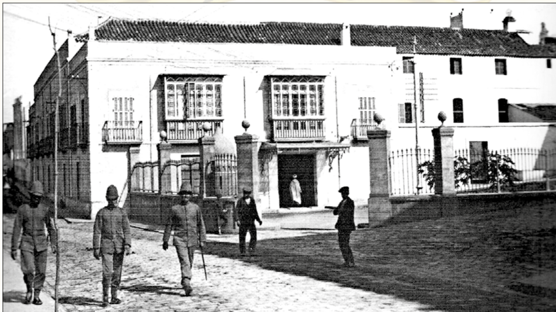
Edificio de la Comandancia General de Ceuta hacia 1925
