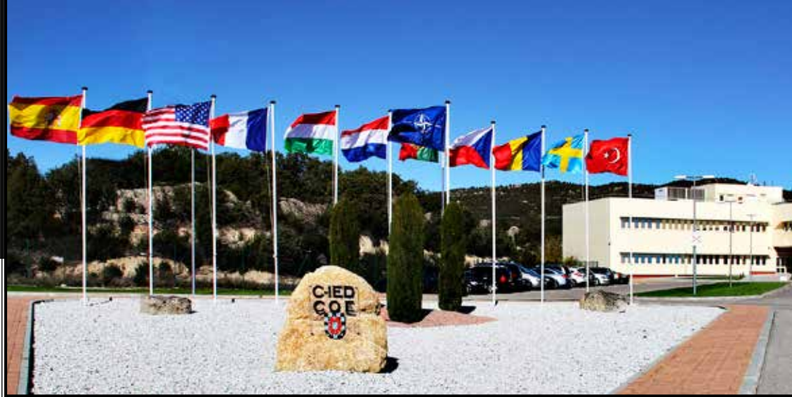
Instalaciones de la sede del COE C-IED en Hoyo de Manzanares
