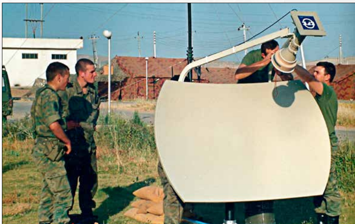
Instalación de la antena de un terminal satélite de la Agencia EFE
