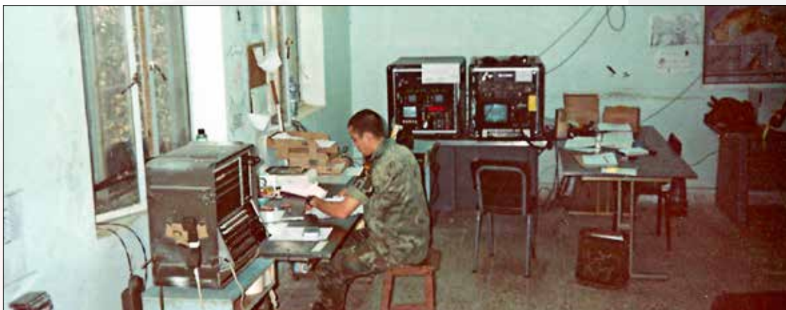
CTPC de la AGT (Zahko). Se observa al fondo el sondador ionosférico y a la izquierda la central de telefonía manual ABM-1015
