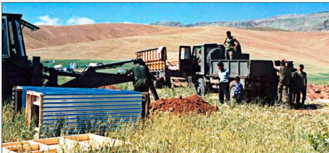
Adecuación de instalaciones
