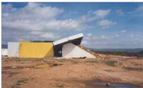
Pruebas de un depósito modular de municiones y explosivos
