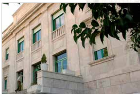
Edificio de aulas de la Escuela Politécnica Superior del Ejército
