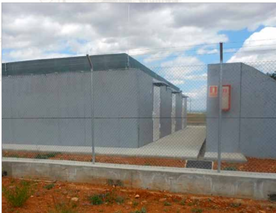
Depósito modular construido
