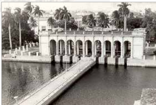
Depósito de regulación de la red de agua de La Habana, 1893
