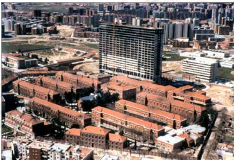
Construcción del nuevo hospital Gómez Ulla
