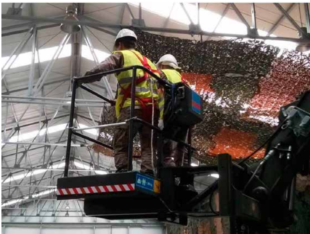
Trabajadores en plena actividad
