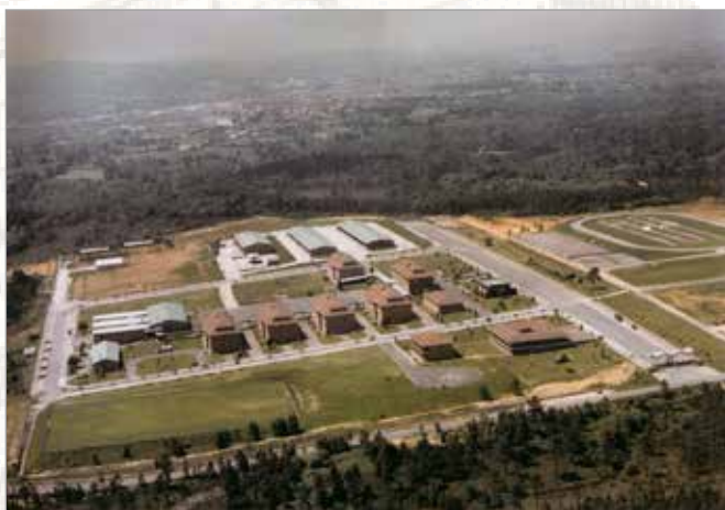
Vista aérea del acuartelamiento Cabo Noval, Pola de Siero
