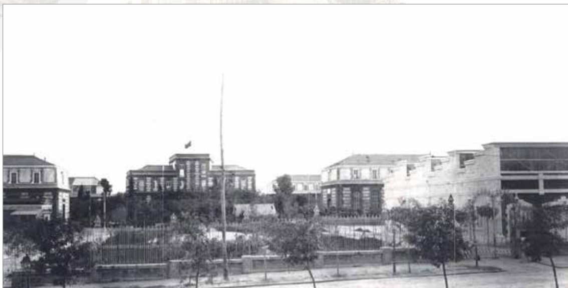
Vista general del Taller de Precisión y Centro Electrotécnico de Artillería
