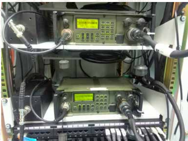
Radioteléfono VHF PR4G en banco de pruebas
