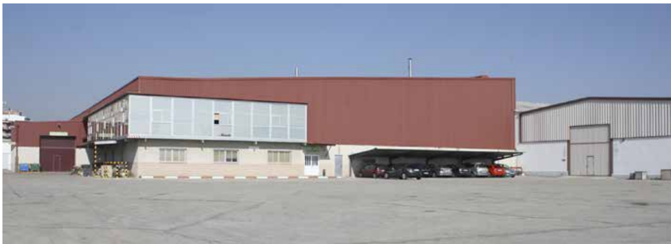
Unidad de abastecimiento
