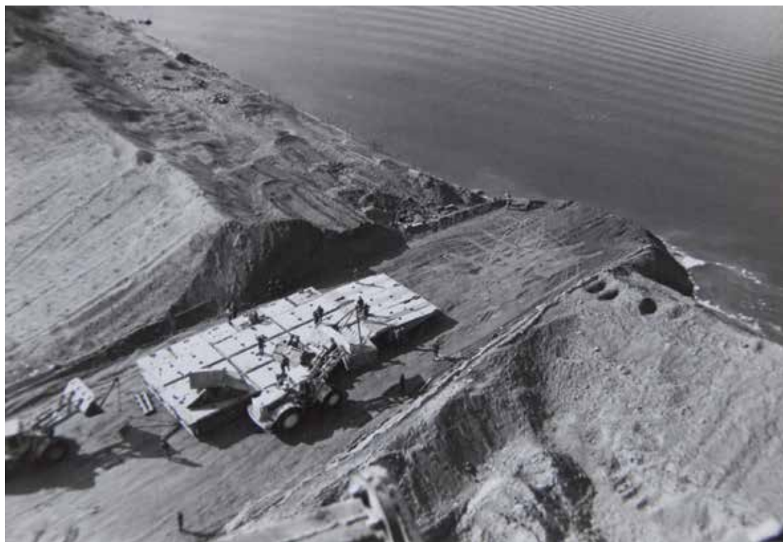
Trabajos de mantenimiento
