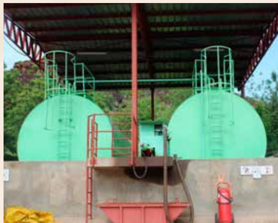
Depósitos de combustible
