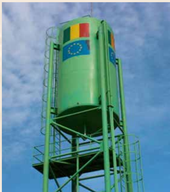
Depósito de agua en el KTC (Koulikoro Training Camp)
