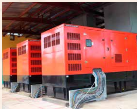
Generadores principales del KTC
