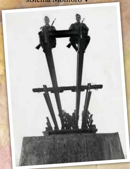
Puente CGI: Lanzamiento por el sistema Montoro ▼
