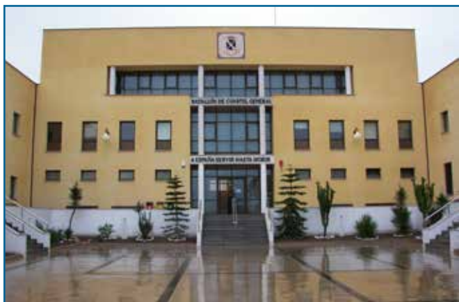
Fachada del edificio del Batallón del Cuartel General
