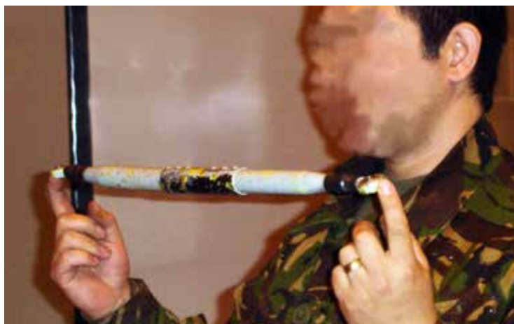
Reparación expeditiva de conexiones mecánicas
