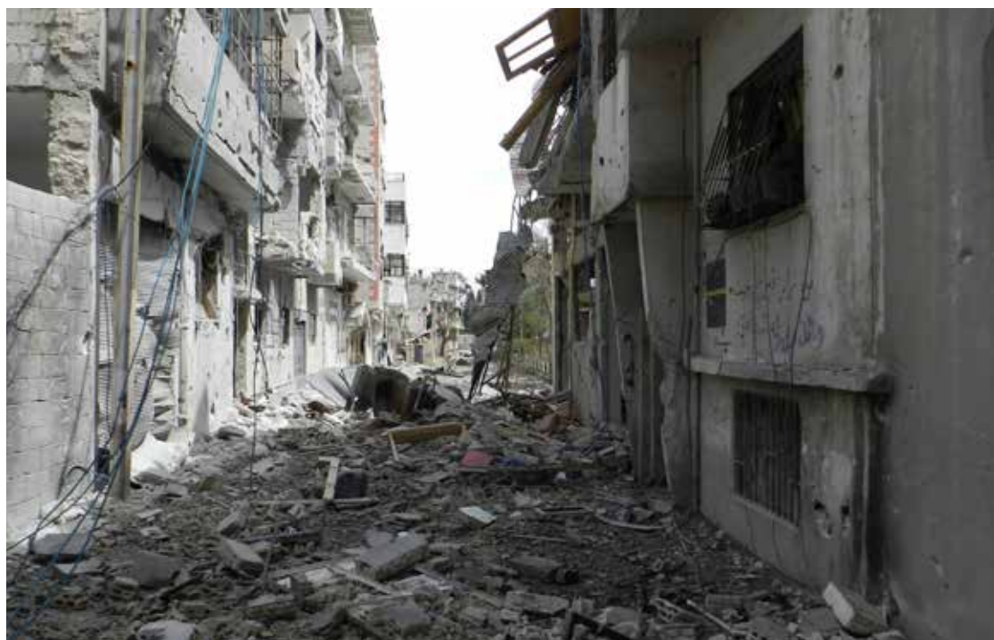
Edificaciones destruidas durante el conflicto en la ciudad de Homs
