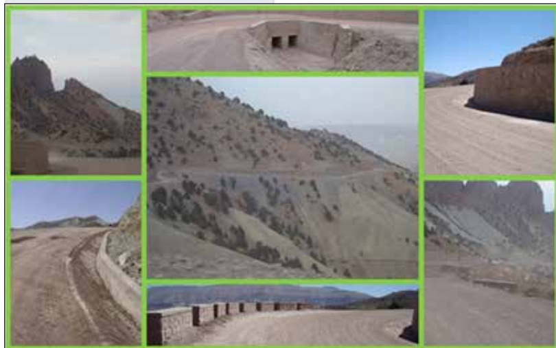
Trabajos de rehabilitación de caminos
