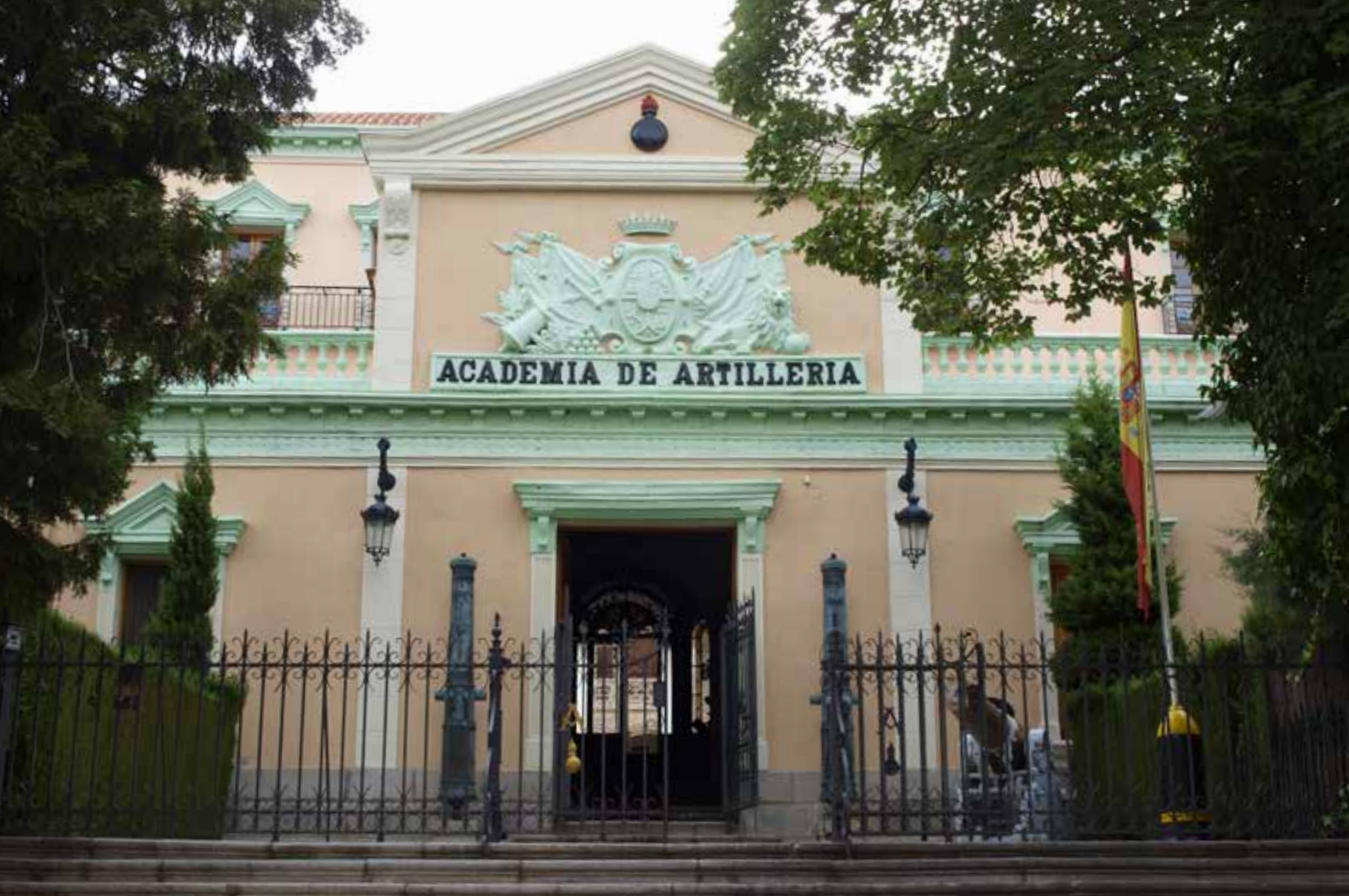
Entrada principal de la Academia de Artillería
