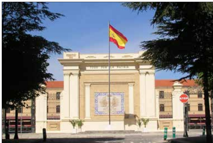
Zona central y entradas al patio
