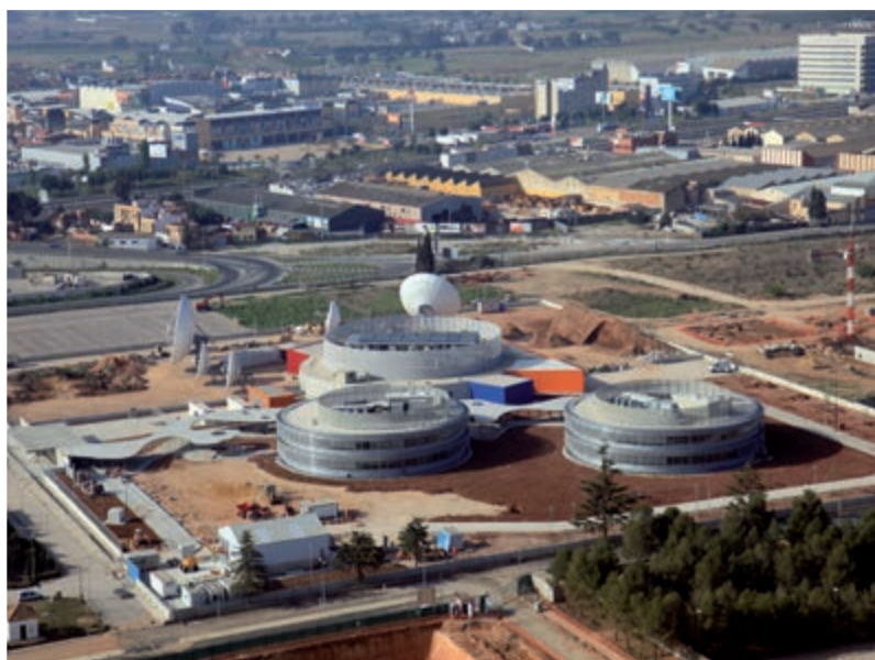
Centro de Comunicaciones y Datos para Operaciones de Mantenimiento de Paz de la ONU en Quart Poblet, Valencia (2009-2011)
