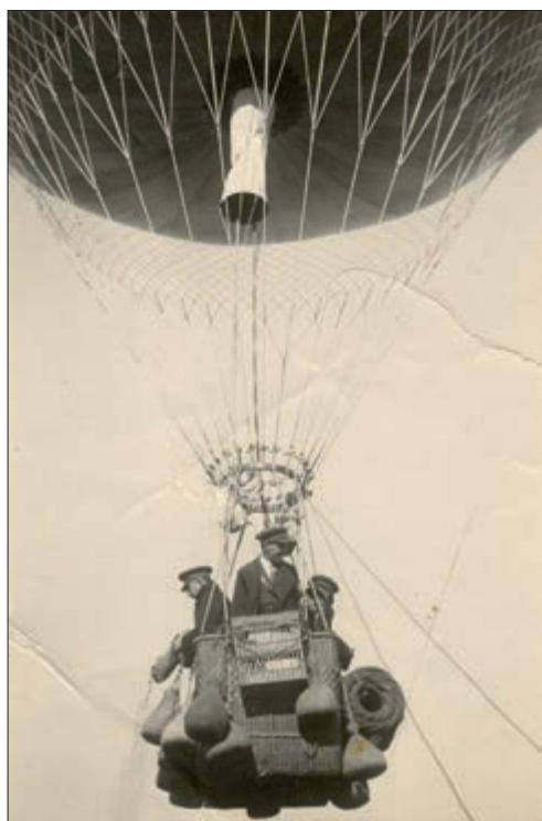
Barquilla de un globo libre en la que se aprecia el cabo moderador, los sacos de lastre y otros equipamientos
