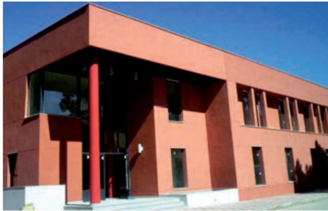
Edificio administrativo para el Centro Universitario de la Defensa de la Academia General Militar de Zaragoza.
