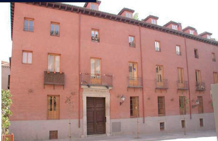
Quinta sede de la Escuela en el Palacio del Conde de Miranda
