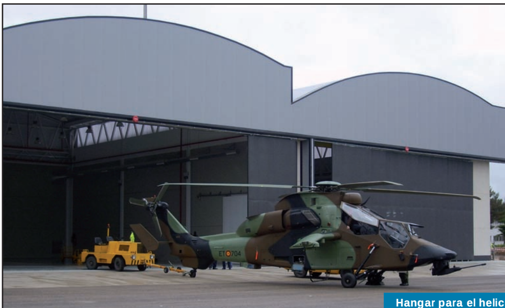
Hangar para el helicóptero Tigre. Base Coronel Sánchez Bilbao. Almagro
