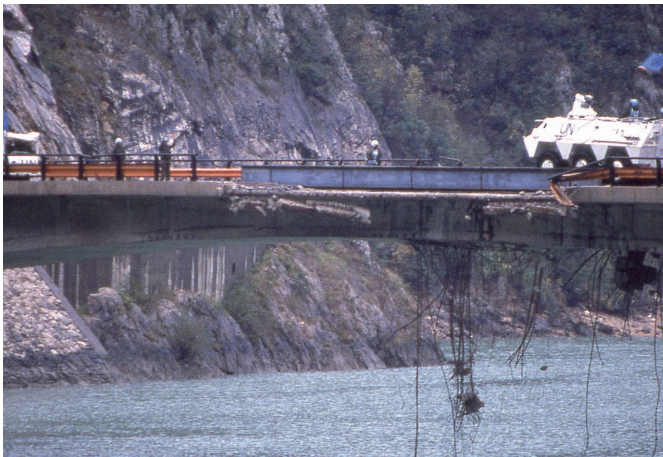
Puente sobre el río Neretva
