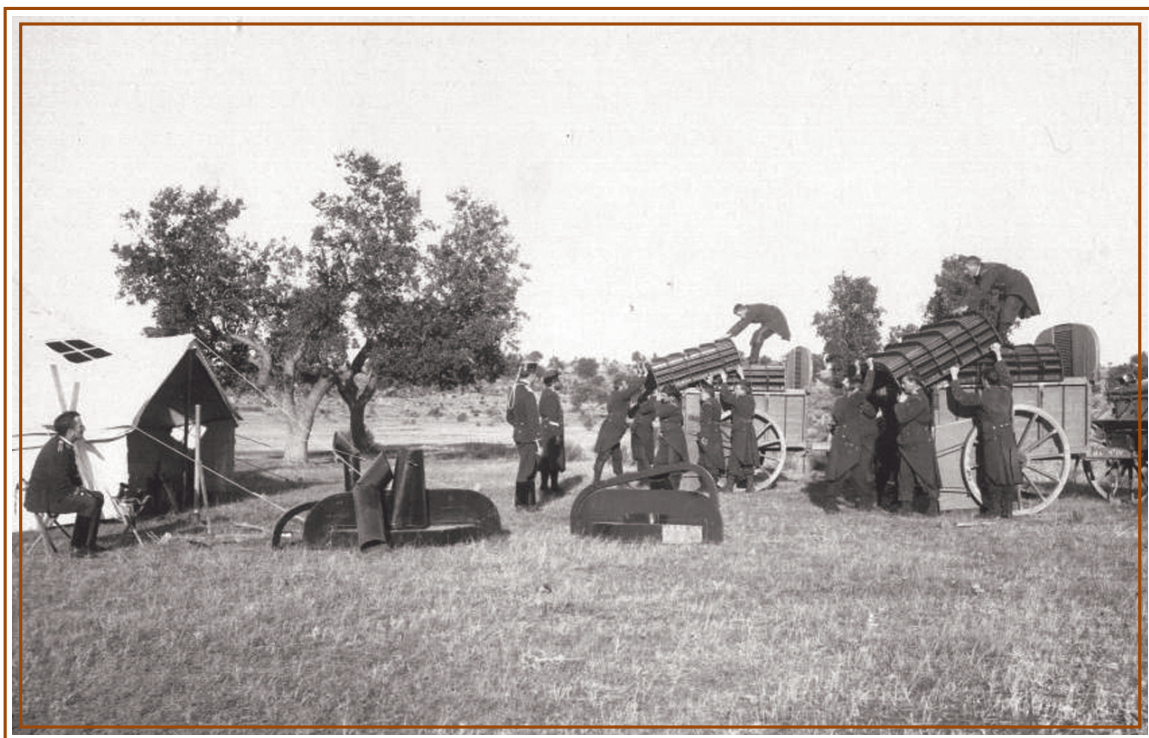
Descarga de Témpanos
