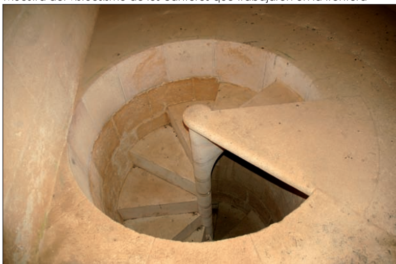
Escalera de caracol en la caponera del hornabeque. Muestra del vistuosismo de los canteros que trabajaron en la frontera
