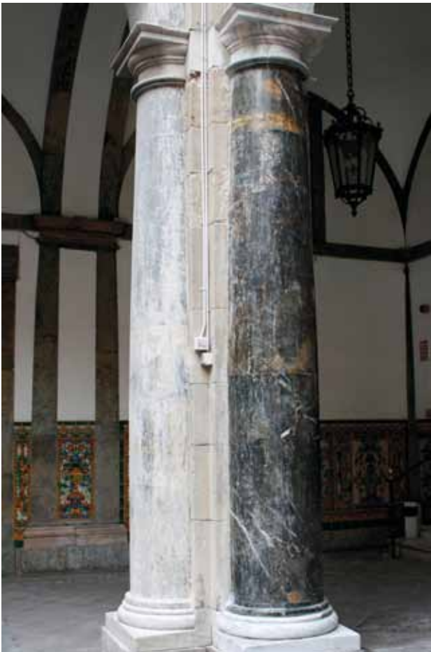
Pulido de las columnas del claustro
