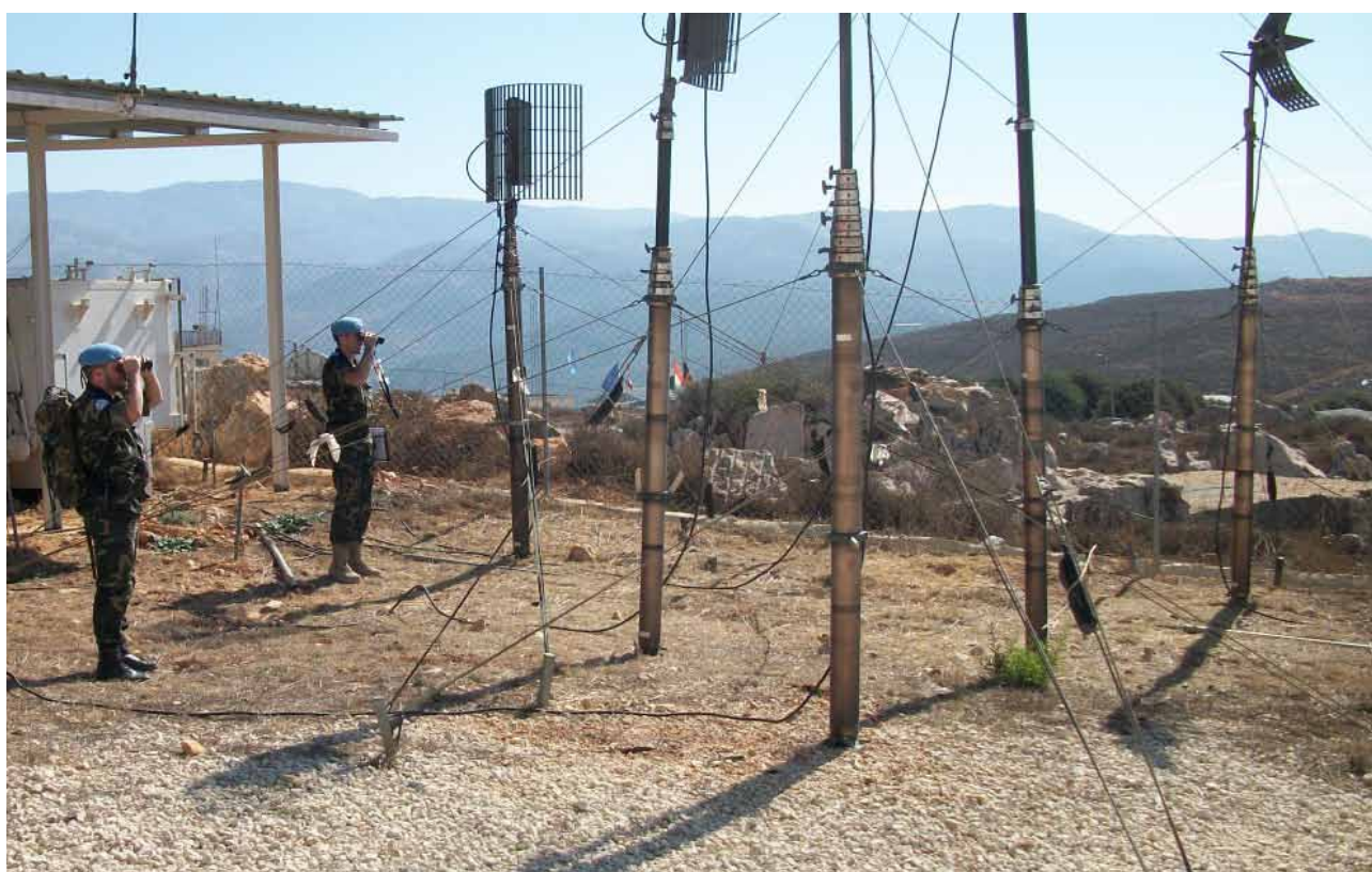
Un equipo del CIP ha modernizado las comunicaciones en el Líbano
