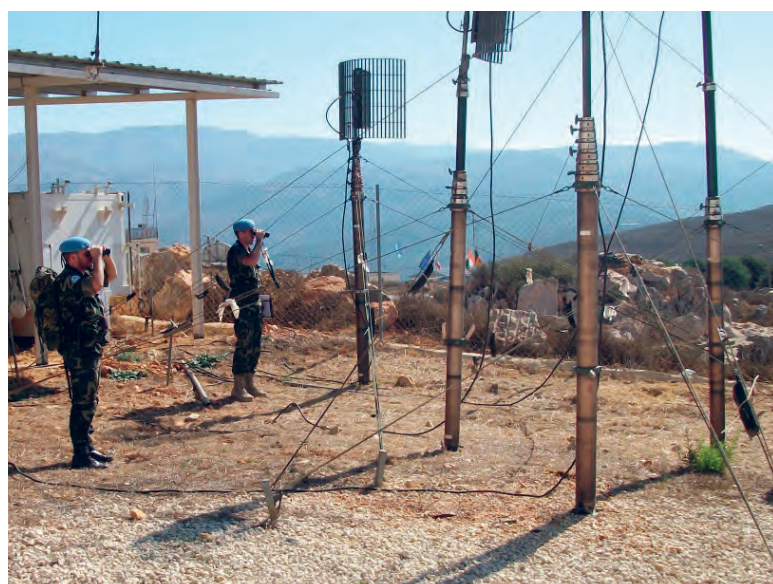
Un equipo del CIP ha modernizado las comunicaciones en el Líbano
